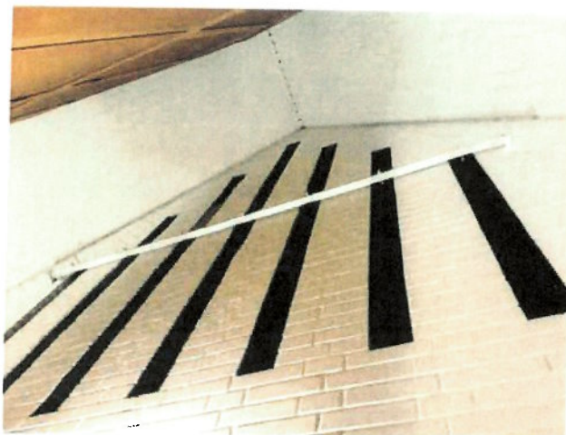
Eksisterende røglemme i nordgavlen
