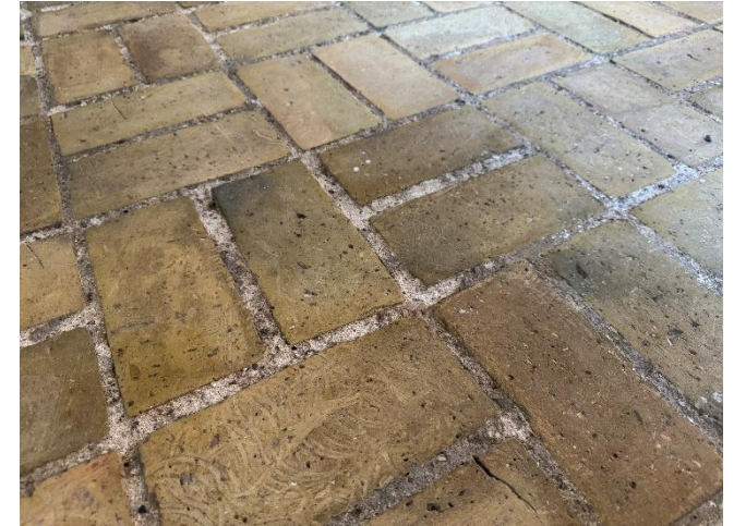
09 – Fuger i teglstengulv efterfyldes
