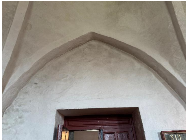
11 – Revne mod våbenhus holdes under OBS
