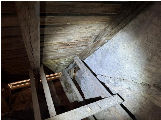
04 – Fugt mellem skib og tårn holdes under OBS
