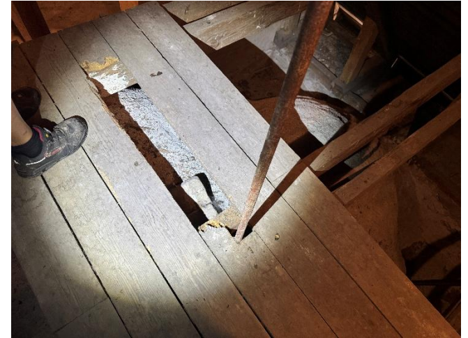
03 – Gangbro over skib udbedres
