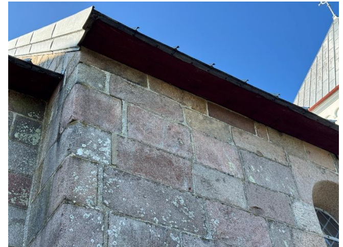
06 – Fuger i kvaderstensmurværk gennemgås
