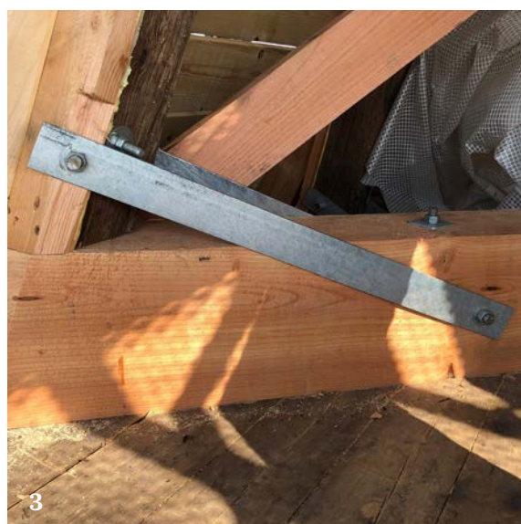
1. Hjallerup Kirke 2+3: Forstærkning af spærfod: Udskiftning af fodrem samt udførelse af nye nakkebånd
