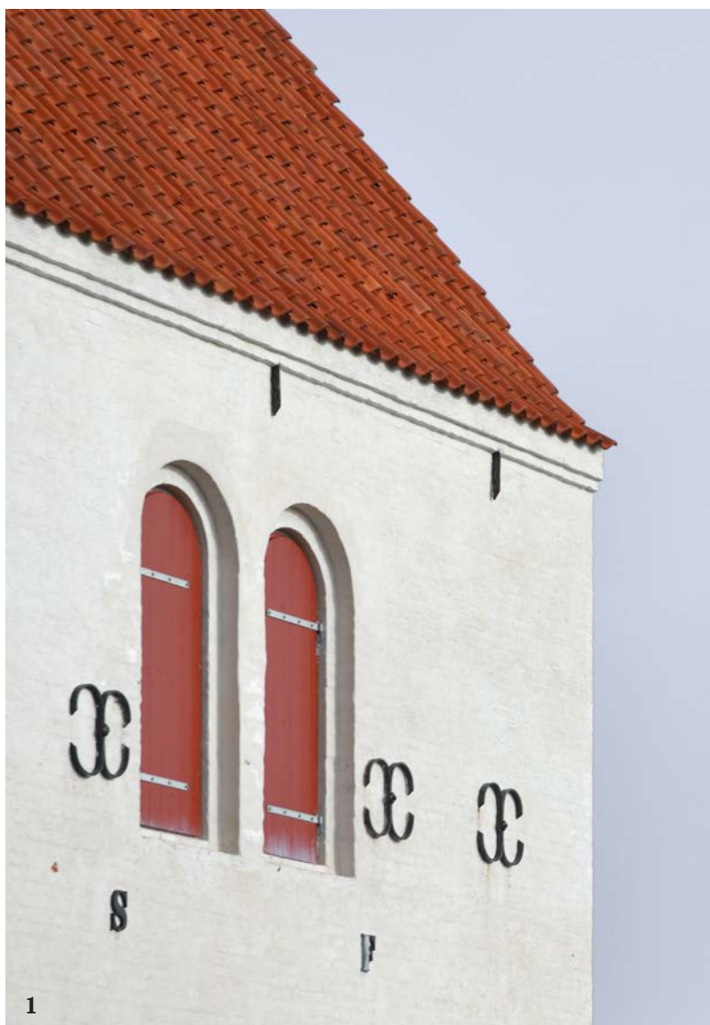
1. Reetablerede glamhuller 2. Vennebjerg Kirke 3. Restaureret facade i kvadersten
