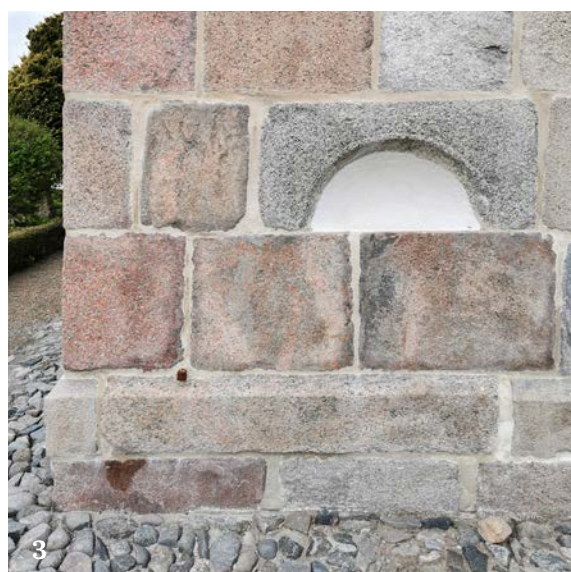
1. Reetablerede glamhuller 2. Vennebjerg Kirke 3. Restaureret facade i kvadersten
