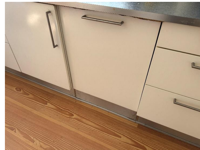
06 – Opvaskemaskine justeres og sokkel tilpasses
