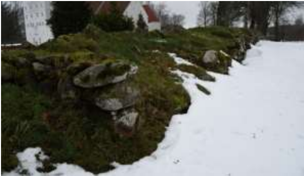
Foto 4. Udskredet parti på østdigets sydlige del
