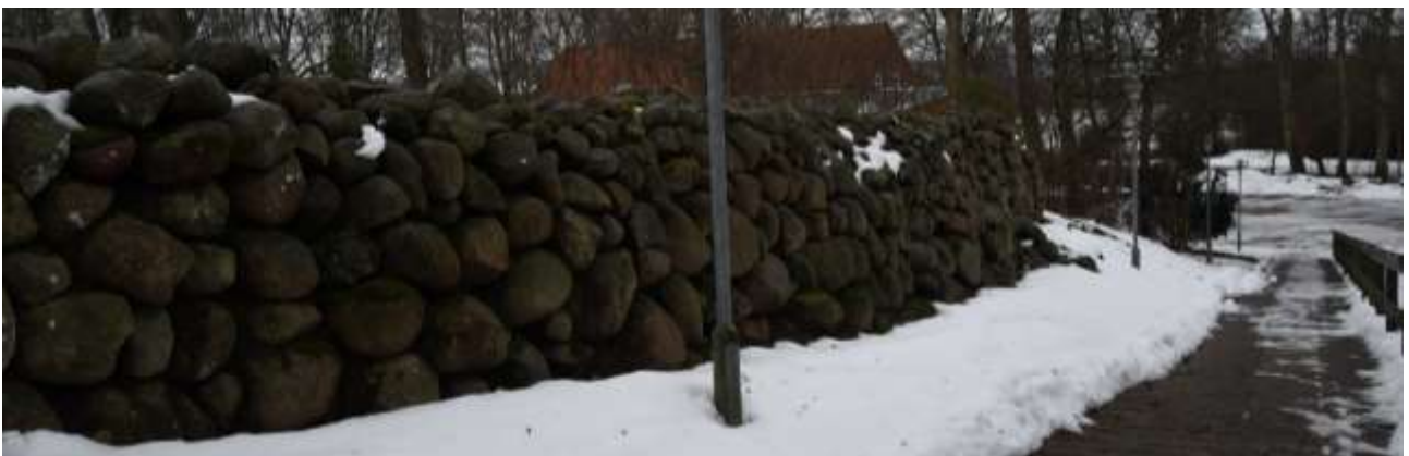
Foto 10. Ved vestdigets sydlige del er der afgravet terræn for anlæggelse af en sti. Det medfører en høj udvendig digeside
