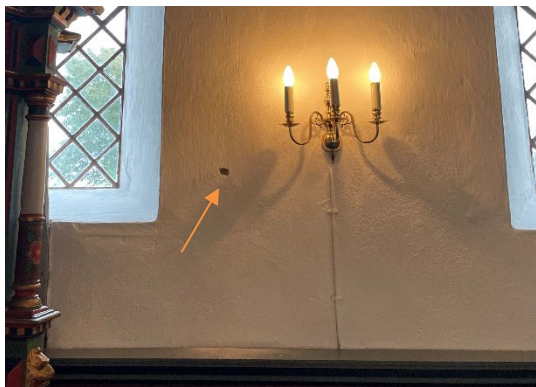
Fig. 1. Skib, sydvæg med markering af punkt 1.
