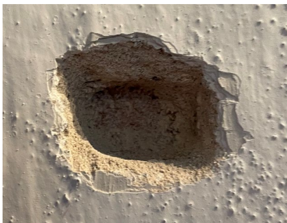
Fig. 2. Skib, sydvæg. Lagvis afdækning af punkt 1.
