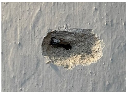
Fig. 5. Skib, nordvæg. Lagvis afdækning af punkt 2.
