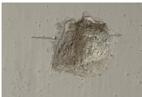
Fig. 4. Skib, nordvæg. Lagvis afdækning af punkt 2.
