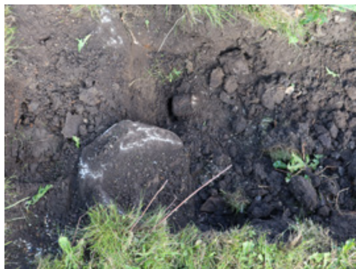
Syddiget snit 1 (digetop). Blotlægning af indvendig digetop.
