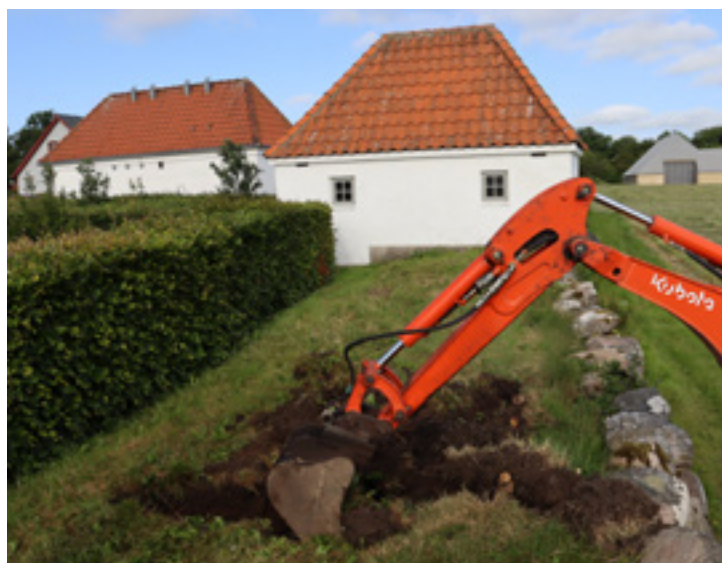
Syddiget snit 1 (digetop). Fritgravning af digetop.
