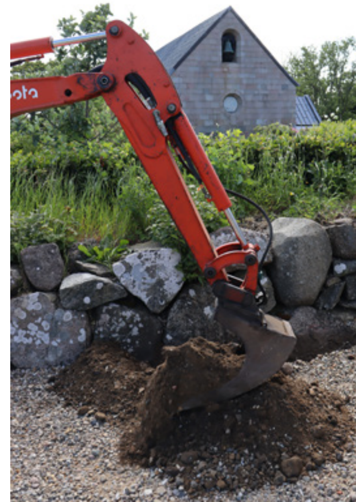
Vestdiget snit 4. Bundstenen er store marksten. Diget over terræn er delvist sammenfaldet og suppleret med tilfældige stenmaterialer.
