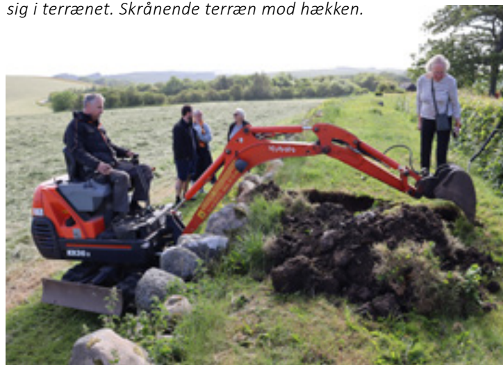
Norddiget (digetop) ud for apsis. Fritgravning af digetop.
