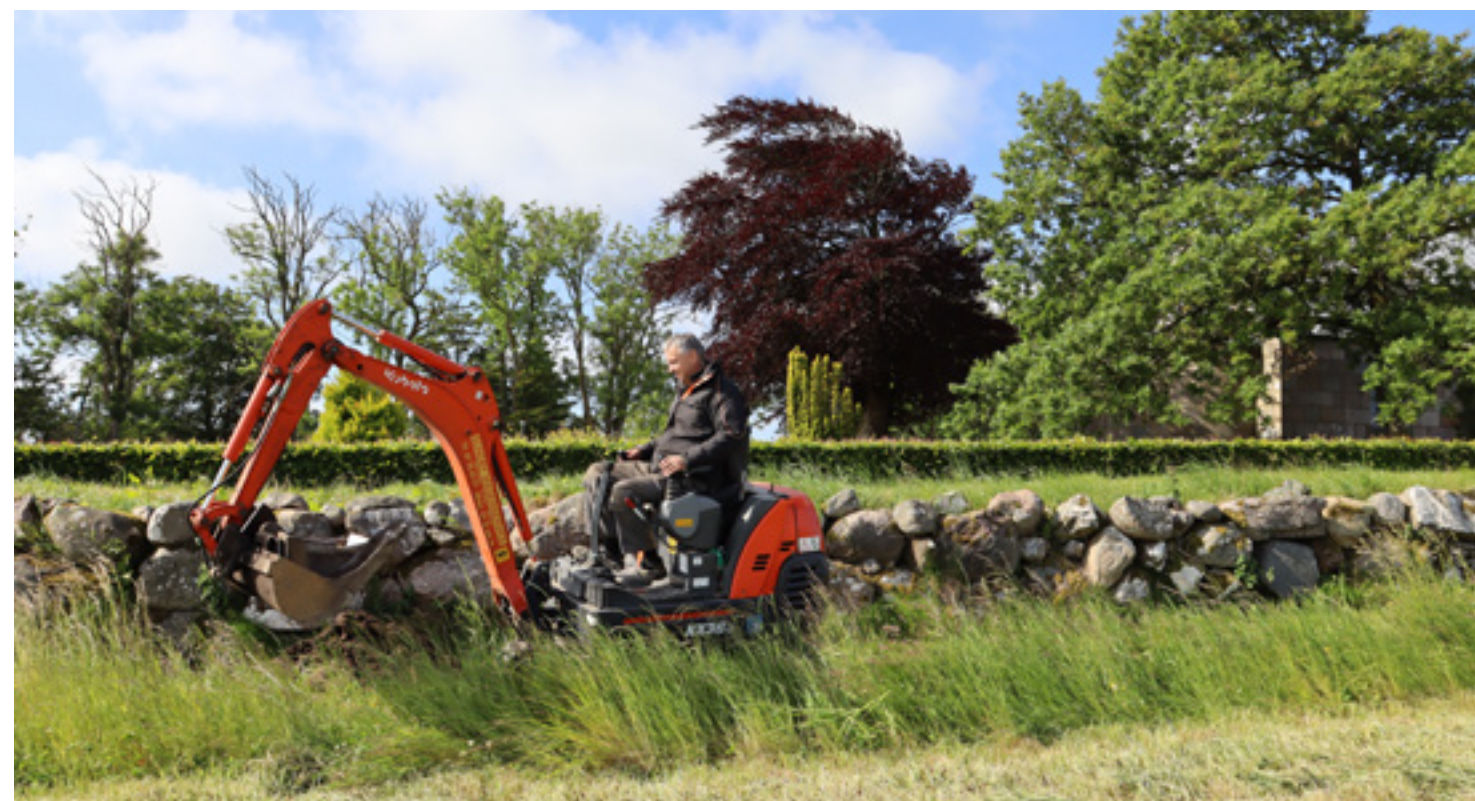
Norrdiget snit 2. Digetoppen ligger ca. 100 - 120 cm over terræn.
