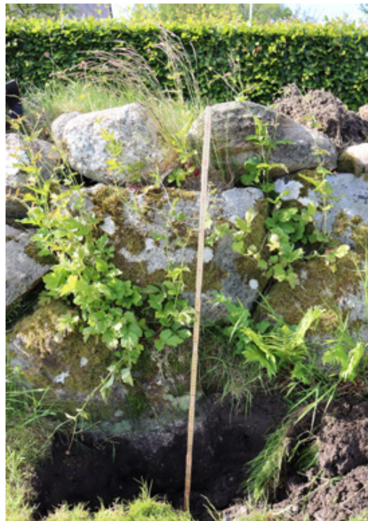
Syddiget snit 1. Dobeltdige med græsbeklædt digetop. Indvendig digesider er jorddækket. Højde over terræn ca. 100 cm.
