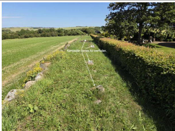
På top af det nordlige dige fjernes kampesten fra overfladen og der reguleres med jord.
