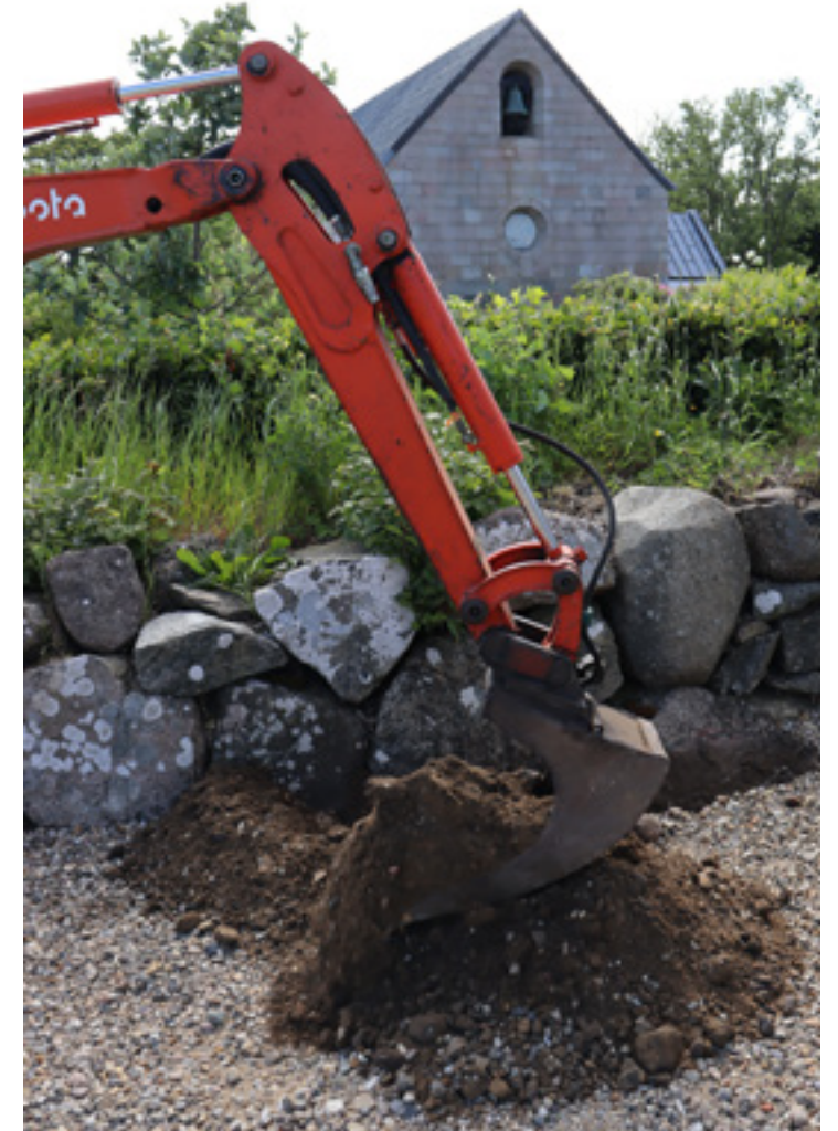
Vestdiget snit 4. Bundstenen er store marksten. Diget over terræn er delvist sammenfaldet og suppleret med tilfældige stenmaterialer.
