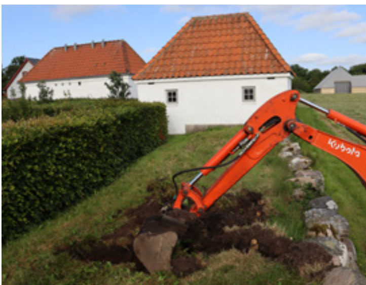
Syddiget snit 1 (digetop). Fritgravning af digetop.
