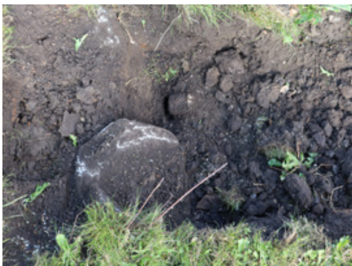
Syddiget snit 1 (digetop). Blotlægning af indvendig digetop.
