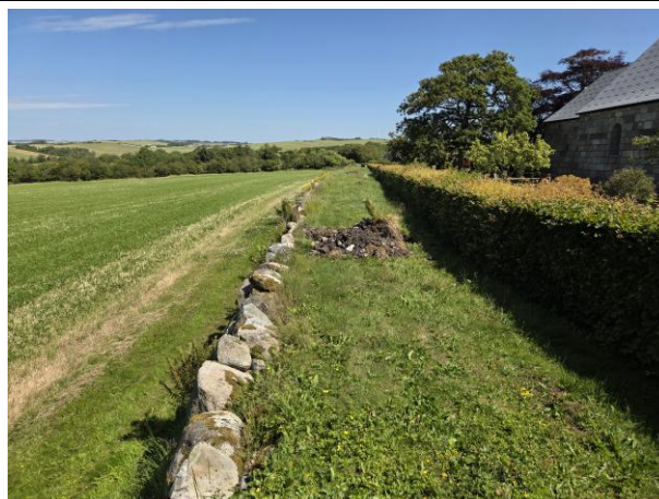
På top af det nordlige dige fjernes kampesten fra overfladen og der reguleres med jord.
