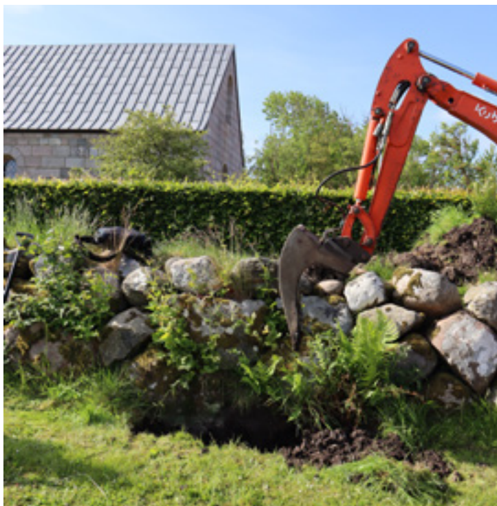
Syddiget snit 1. Blotlægning af bundsten.
