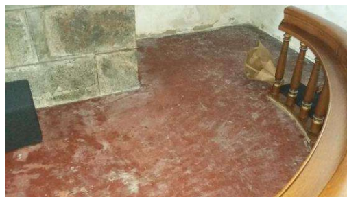
Forhøjet gulv ved alter
