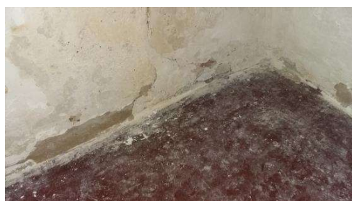
Forhøjet gulv ved alter
