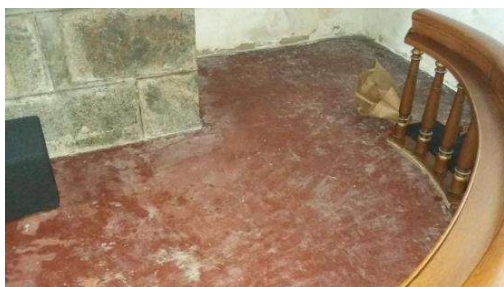
Forhøjet gulv ved alter
