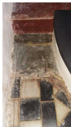
Gulv med fliser ved forhøjet gulv mellem væg og knæfald (mod nord)
