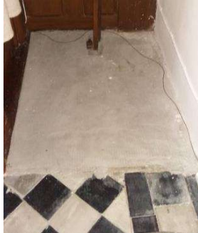
Gulv hvor der er betonstøbt overflade. (mod nord) Bag væg udført som træpanel
