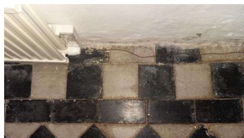
Gulv langs væg (mod syd)
