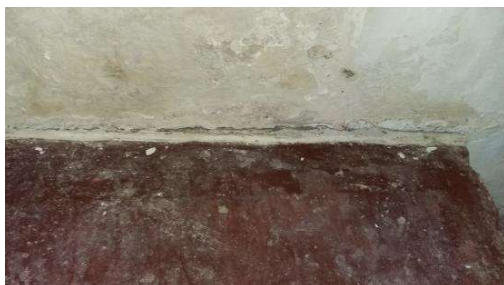
Forhøjet gulv ved alter
