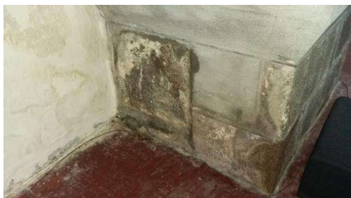
Forhøjet gulv ved alter
