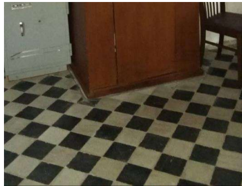
Gulv ved depotrum (mod syd)
