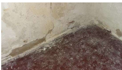
Forhøjet gulv ved alter
