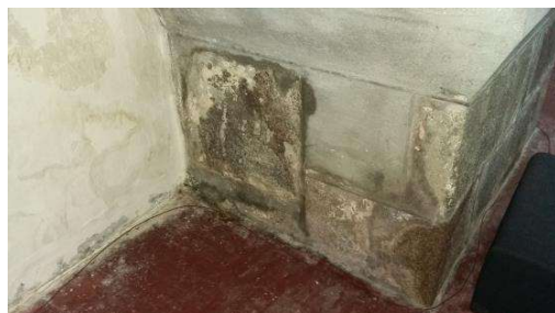
Forhøjet gulv ved alter
