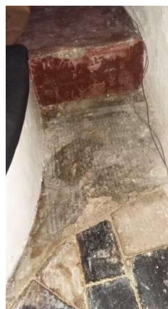
Gulv med fliser ved forhøjet gulv mellem væg og knæfald (mod syd)
