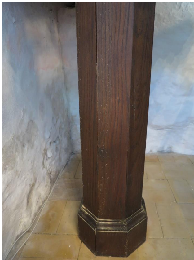
Borebilleangreb på bjælkers støttekonstruktion og på prædikestolens fods afdækningsplader.
