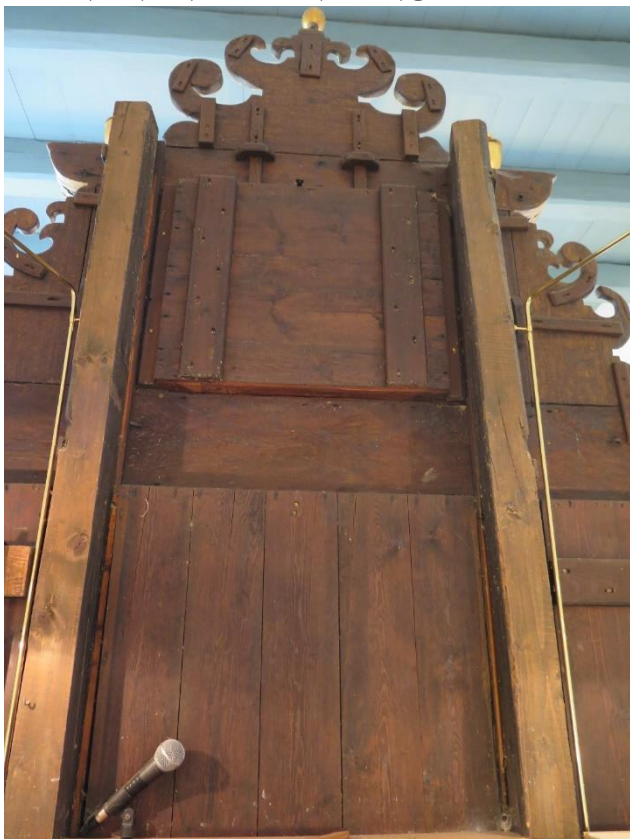
Borebilleangreb på bjælkers støttekonstruktion og på prædikestolens fods afdækningsplader.
