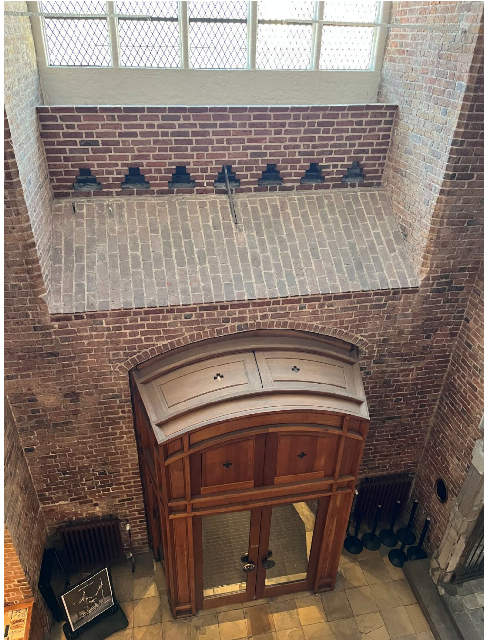
Foto af vinduet set indefra. Her ses den øverste del af den klakede brystningsmur og foran denne, den murede radiatorskjuler.
