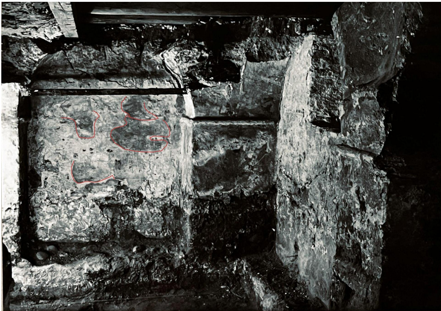
For at tydeliggøre hvor velbevaret muren er, er der med rødt optegnet markante farveforskelle der stadigvæk klart kan erkendes – se nedenfor.
