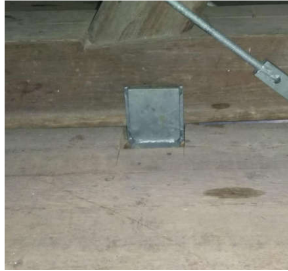
Beslag/sko under lejbjælke fra en anden kirke (Åben model)
