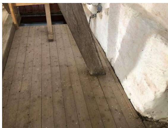
Klokkestolens lejebjælker ligger af på loftets bjælker, loftet er gennembrudt.
