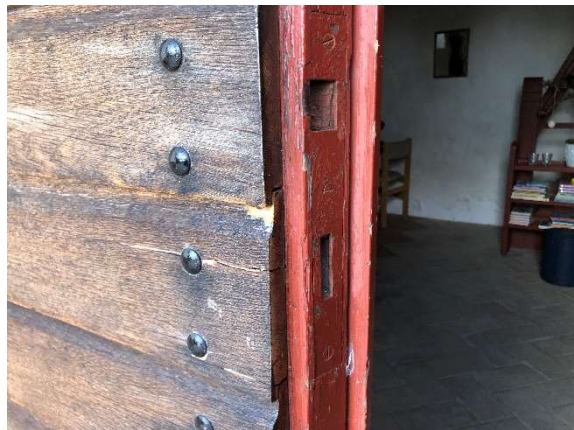
Det forventes at automatikken kan bygges ind i de eksisterende huller, håndtag og langskilte genbruges.
