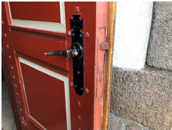
Det forventes at automatikken kan bygges ind i de eksisterende huller, håndtag og langskilte genbruges.
