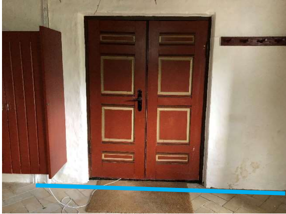
Kablet fremføres i ophugget fuge fra teknikskab til yderdør. (Langs væggen)
