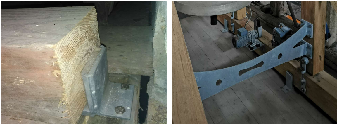
Lejebjælker ligger af åbne beslag/sko med Sylomer, krydset udføre stører. Billeder fra en anden kirke.
