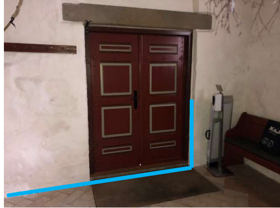
Kablet fremføres i ophugget fuge fra teknikskab til yderdør. (Langs væggen)
