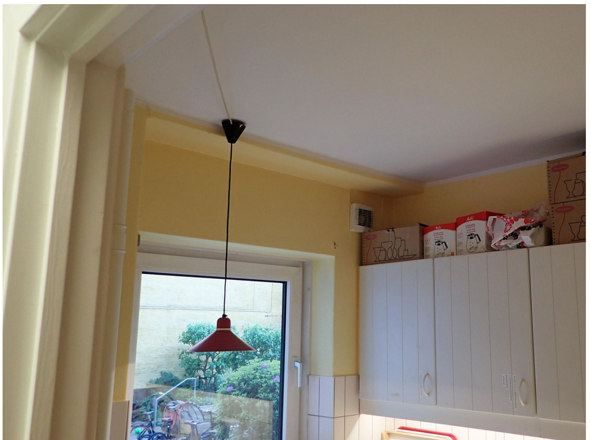
Foto 8 – Køkken, vindue og overskabe
