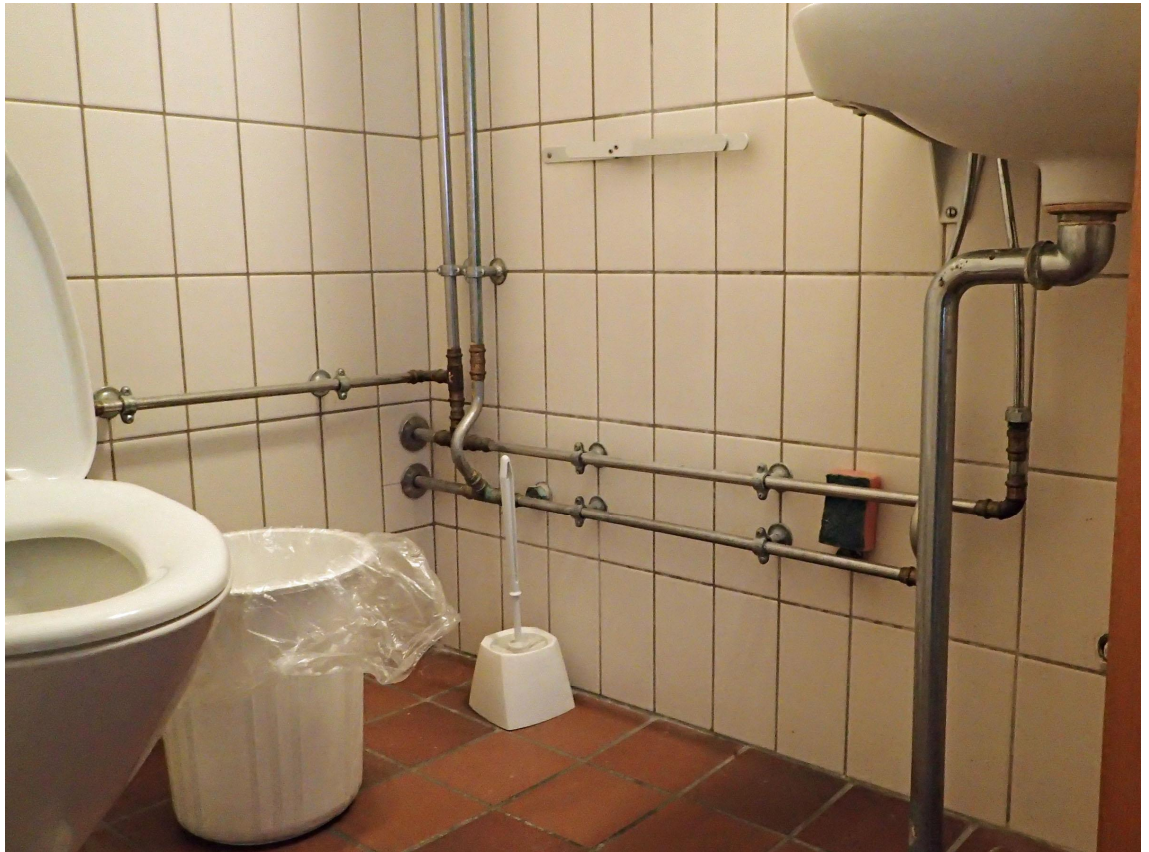
Foto 5 – Toilet, nærbillede af rørføring
