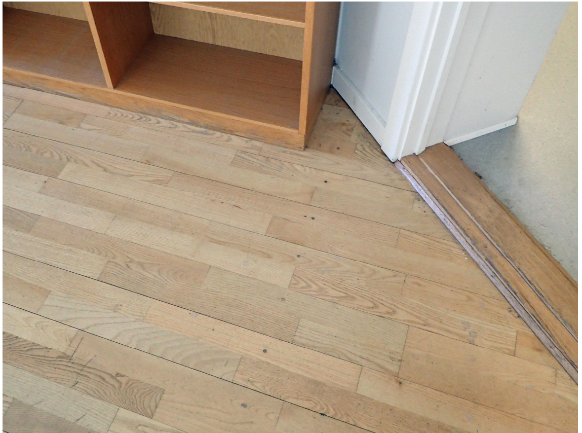
Foto 3 – Bøgeparket i opholdsrum. Grå linoleum i gang og køkken.
