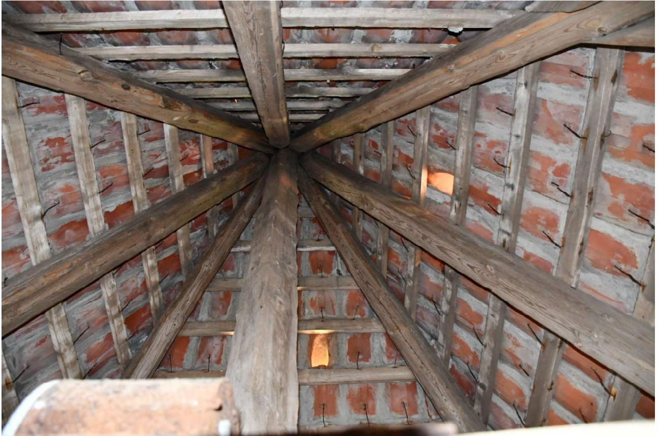
Tagkonstruktion over tårn
