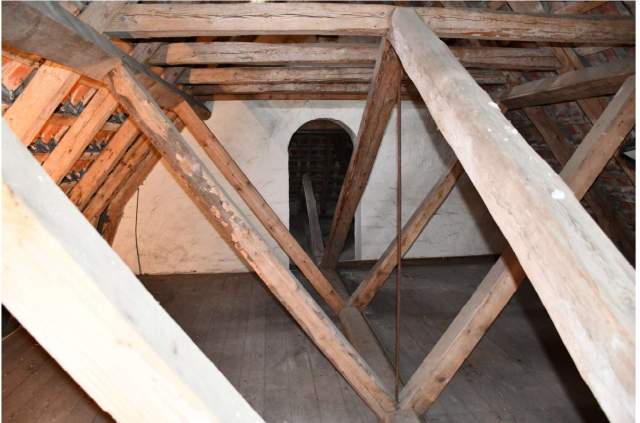
Tagkonstruktion over skib
