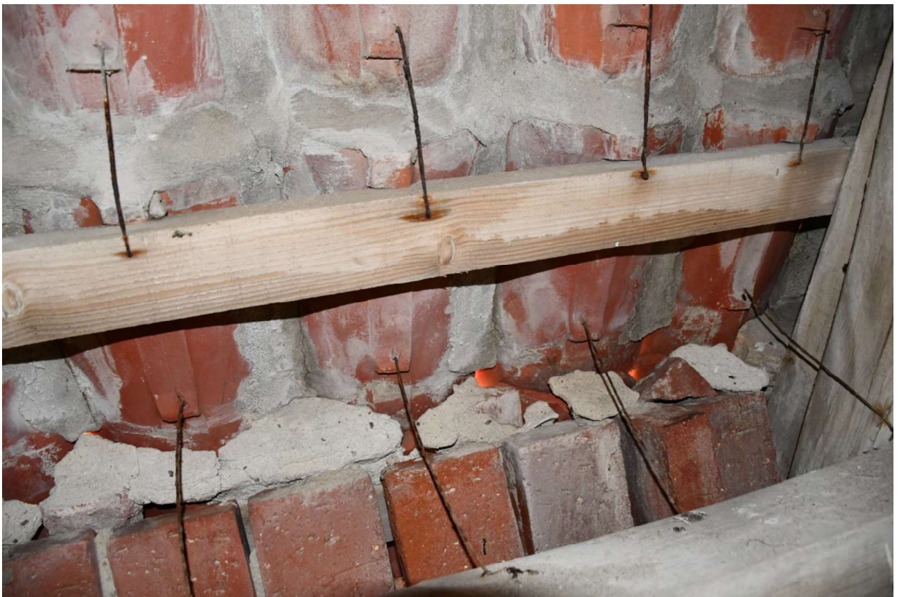
Tagfod over tårn. Bindere er tæt på at være rustet væk.
