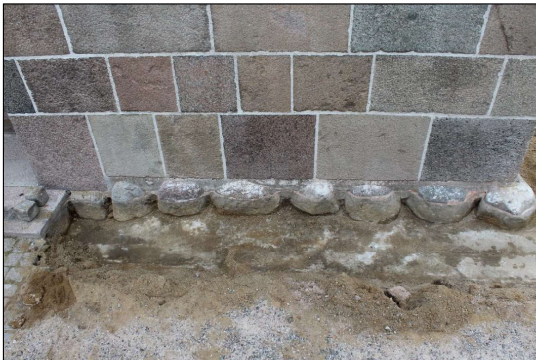
Figur 5: Tårnets vestside, sydlige halvdel: betonplade og fundament. Set fra V
