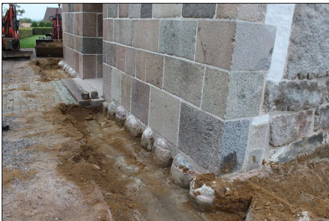
Figur 1: Tårnets vestside, betonplader og fundamentet. Set fra SV
