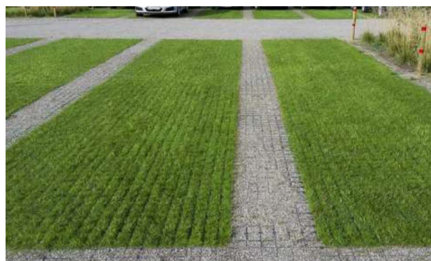
Foto 3. Skråparkering anlægges med græsarmering
