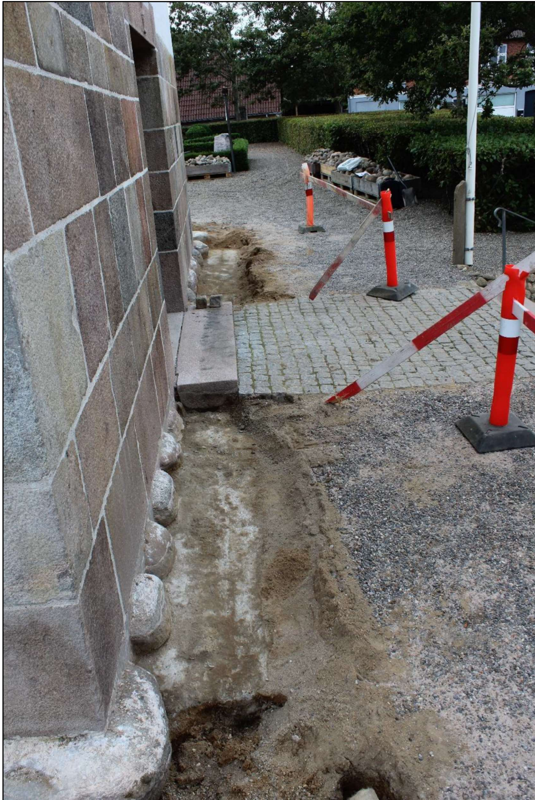
Figur 4: Tårnets vestside, betonplader og fundamentet. Set fra N
