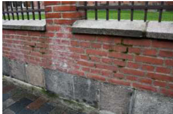
Foto 8. Detalje af muren mod Kirkegårdsgade
