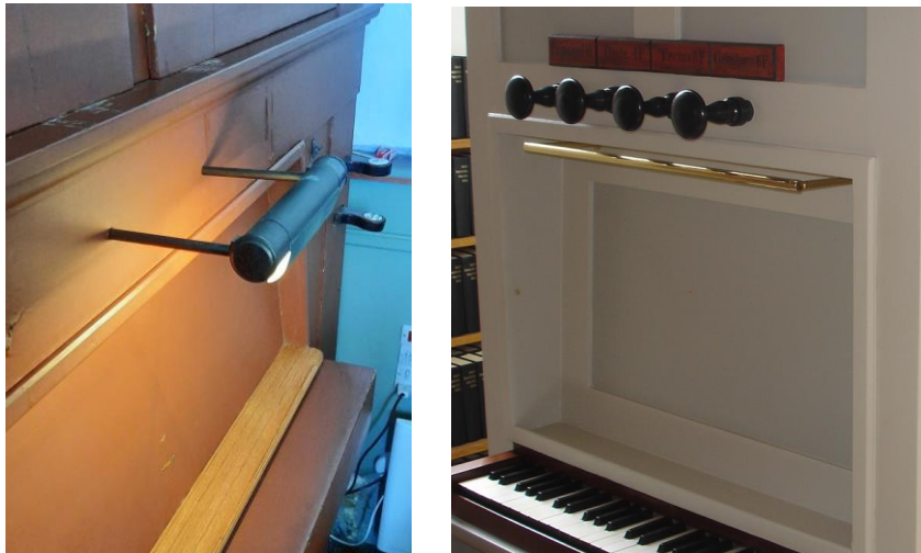
Gl. nodebelysning foreslås udskiftet til LED lyskilde, i messing armatur.
