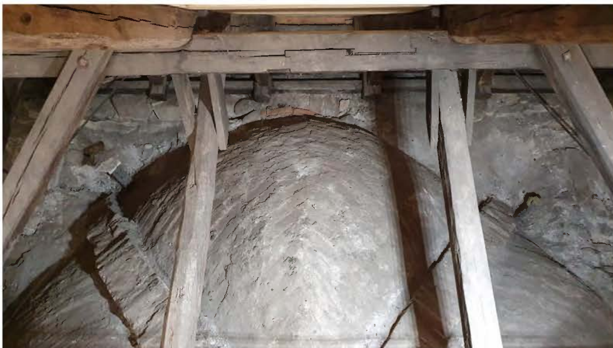
Det midterste hvælv over skibet. Alle hvælv vurderes at være i god bevaringstilstand, uden behov for istandsættelse.
