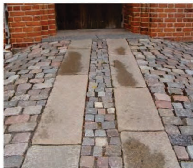
Gamle bordur, chaussé og brosten Sct. Peders Sogns kirke i Næstved
