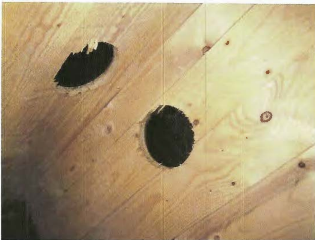
Ventilationshuller i undertag ved kip og tagfod giver god ventilation af tagrum
