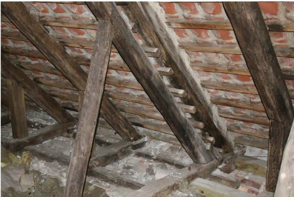
Foto fra 2017. Overgangen mellem forhallens og skibets tagværk, mod syd. I fotografiets nederste venstre hjørne ses isolering over skibets vestligste fag.
