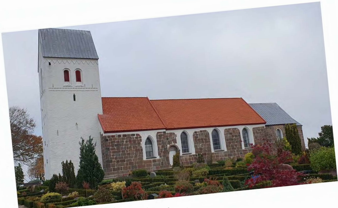
Kirken med tårn, forhal, skib, kor og apsis, set fra syd. Tegltagene over skib og forhal er fornyede i 2018.
