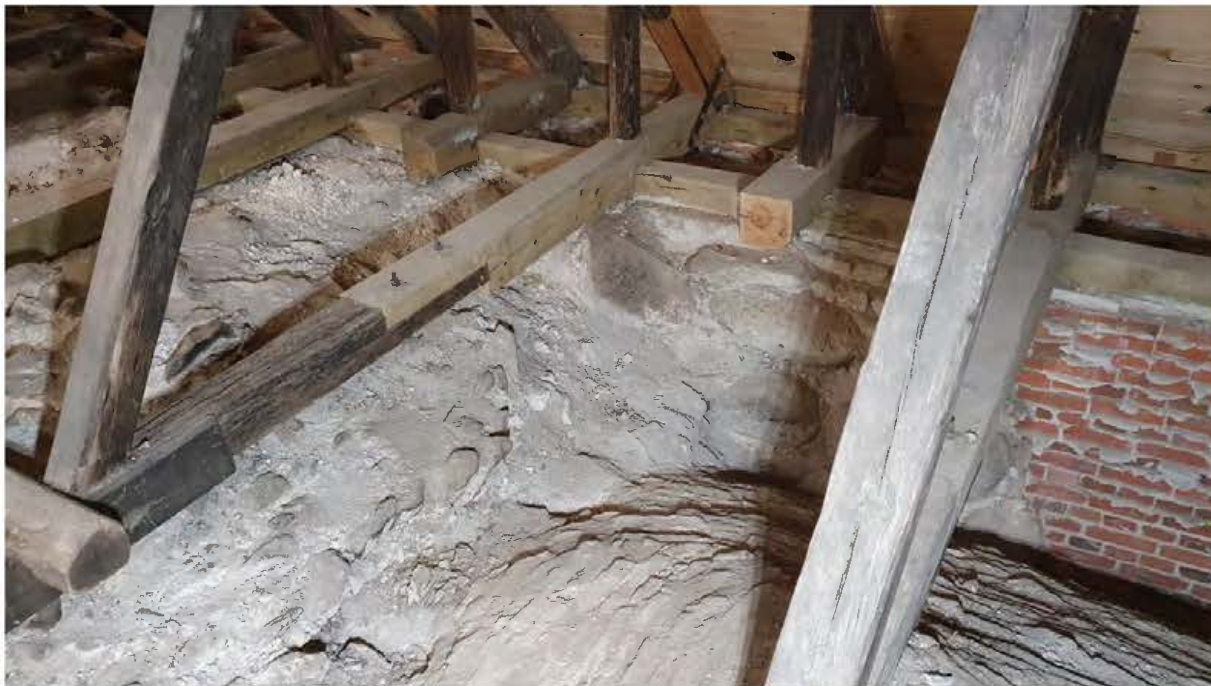
Overgangen mellem forhallens hvælv til venstre og det vestligste hvælv over skibet til højre.
