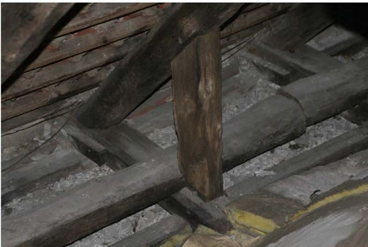
Foto fra 2017. Forhallens tagrum. I fotografiets nederste højre hjørne ses isolering over hvælv.
