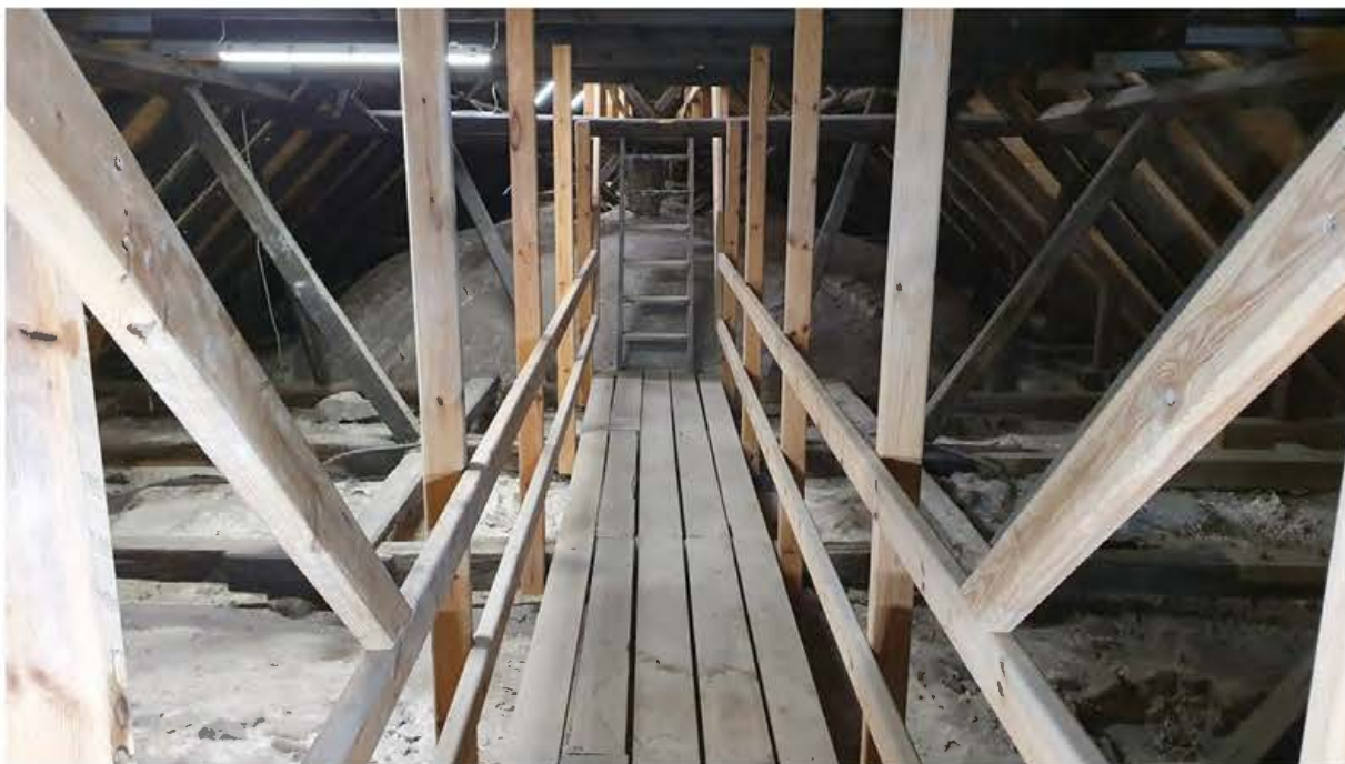
I forgrunden ses hvælvene over forhallen, i baggrunden det vestligste hvælv over skibet.
