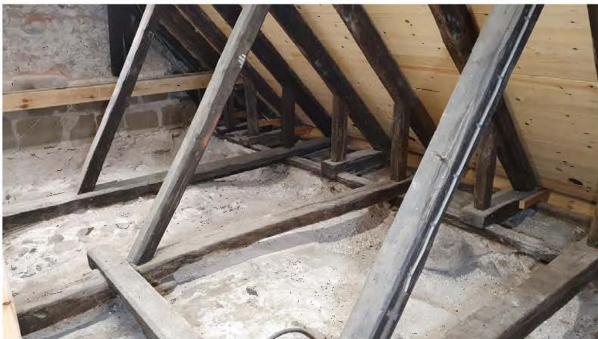
Hvælvene over forhallen, der består af 4 relativt fladbuede hvælv, set mod nordvest.
