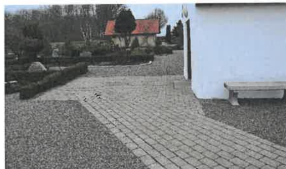
Foto 4. Betonbelægning erstattes af slotsgrus
