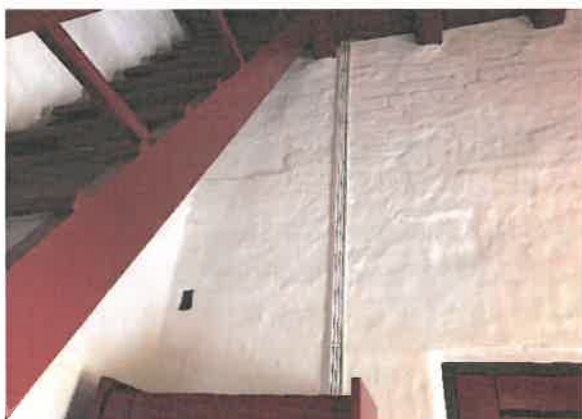
Kablet fra teknikskabet føres til loftet som øvrige kabler. Betjeningen som placeres i skabet.
