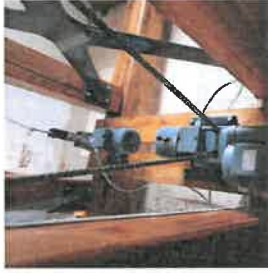
Automatisk ringning og jern kryds mellem lodrette støtter i klokkestol. (Fra en anden kirke)
