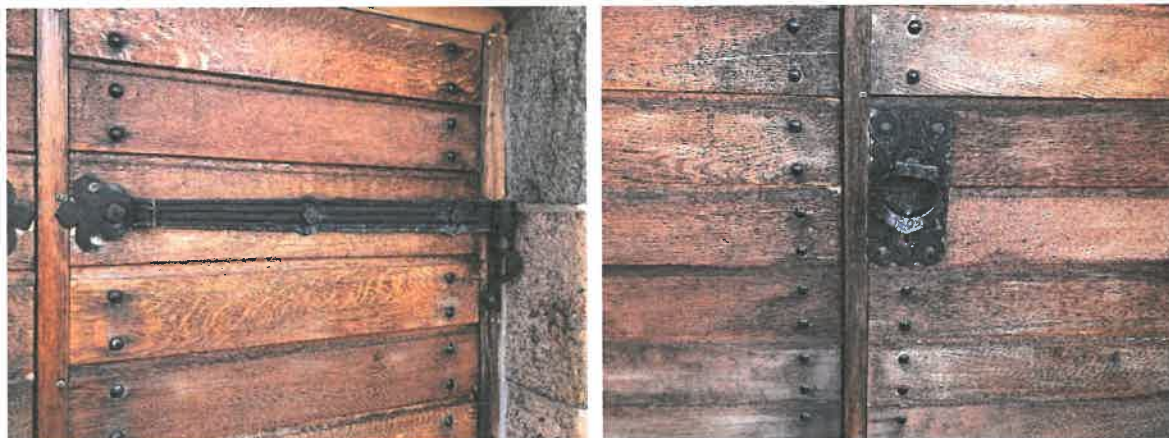
Dørens eksisterende hængsler og dørhåndtag gøres der ikke noget ved, andet servicere hængsler.
