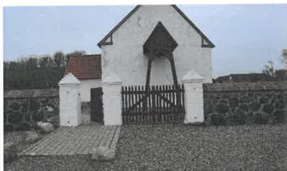
Foto 3. Betonbelægning erstattes af slotsgrus
