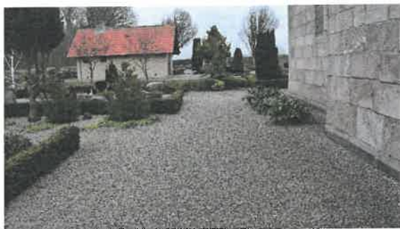
Foto 1. Linjeføring for ny sti mellem våbenhuset og servicebygningen set fra våbenhuset
