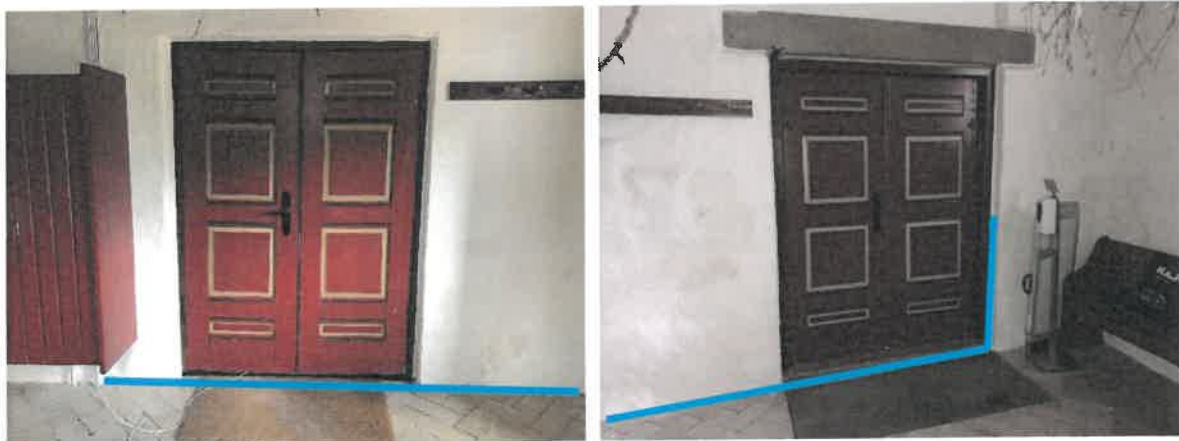
Kablet fremføres i ophugget fuge fra teknikskab til yderdør. (Langs væggene)
