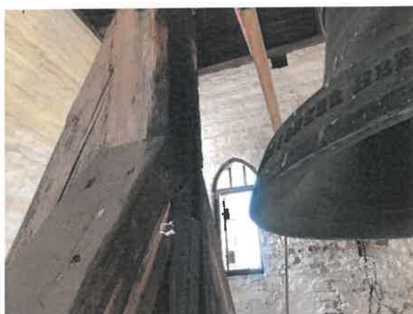
Klokken flyttes ned så den sidder ud for de blivende skråstivninger.
