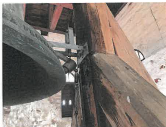
Klokken flyttes ned så den sidder ud for de blivende skråstivninger.
