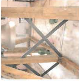
Jern kryds mellem lodrette støtter. (Fra en anden kirke)
