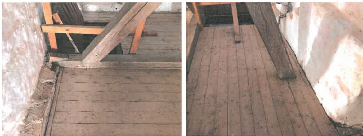
Klokkestolens lejebjælker ligger af på loftets bjælker, loftet er gennembrudt.
