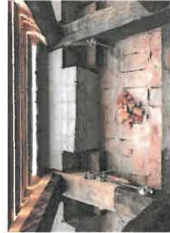
Bindbjælker samlet med O-blok system
