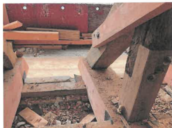
Ny spærstøtte og Istandsatte spærstøtter med løstap i bund. (Billeder fra en anden kirke)
