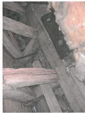
Tagfod fritlagt for isolering
