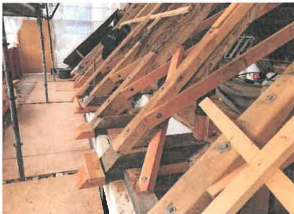
Vindkryds føres fra murrem til kip, hvis det er muligt (Billeder fra en anden kirke)
