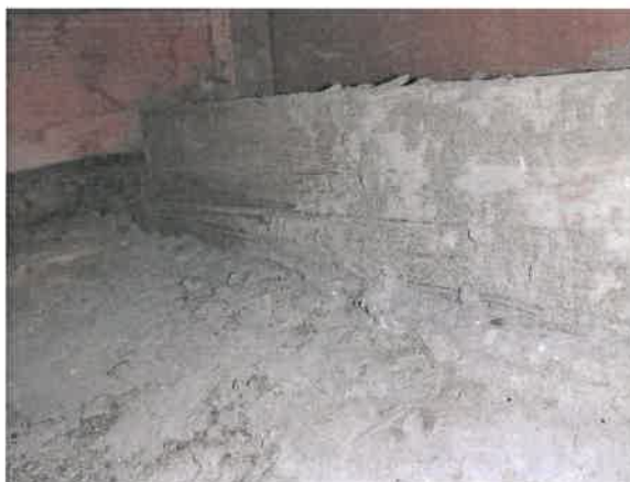
Beton lag i sideskib
