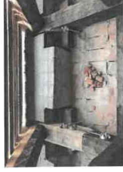
Samling med O blokssystem og forankring til murkroge for vindsug.
