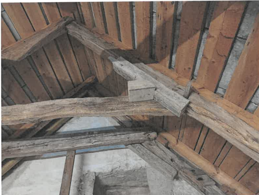
Skibet: Nogle hanebånd udført forkerte, både øverste og nederste.
