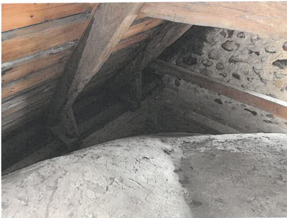
Sakristiet. Tømmer ser ud til at være i god stand, dog istandsat. På brædderne underside ses spor af utætheder.
