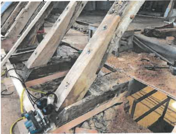
Flere bjælkeender er udlust et stykker i bunden. (Billeder fra en anden kirke)
