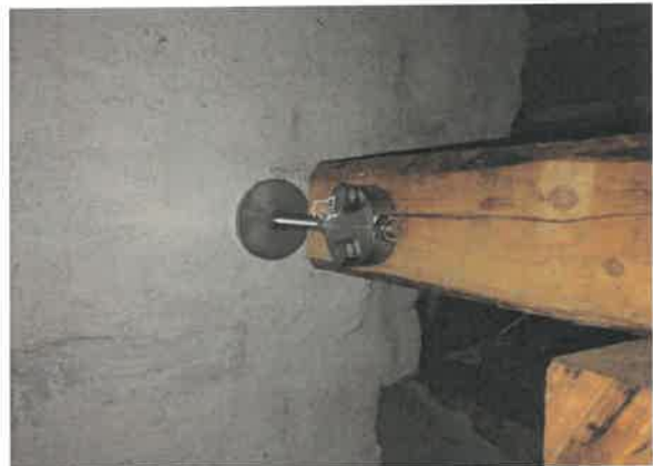
Forankring af gavl til tagkonstruktion med ankerblok (Billeder fra en anden kirke)
