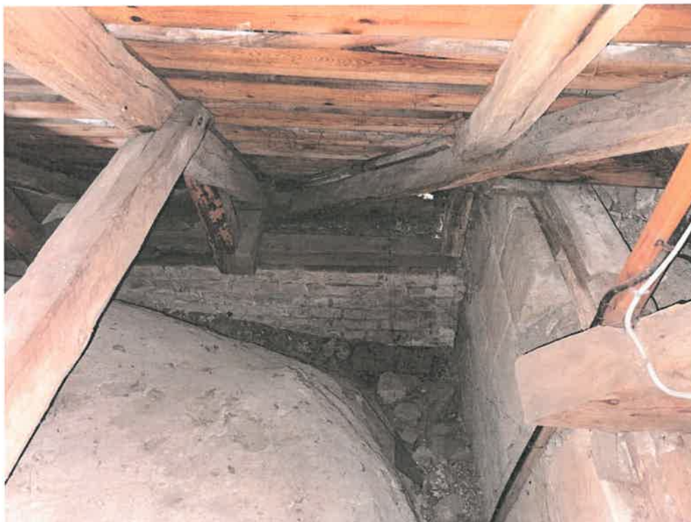
Sakristiet. Tømmer ser ud til at være i god stand, dog istandsat. På brædderne underside ses spor af utæthed.
