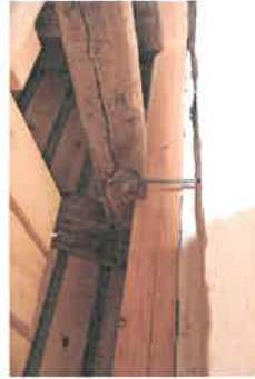
Forankring af tagkonstruktion til murkrone.
