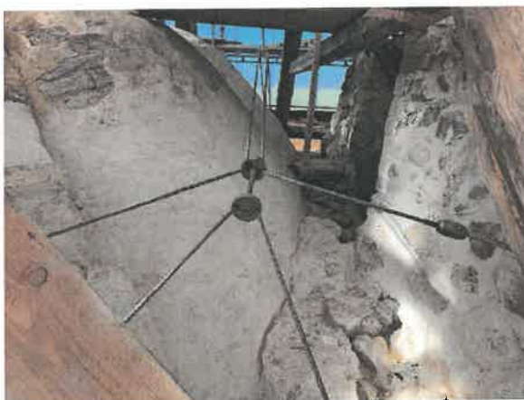
Polygon sammenspænding over hvælv (Billeder fra en anden kirke)
