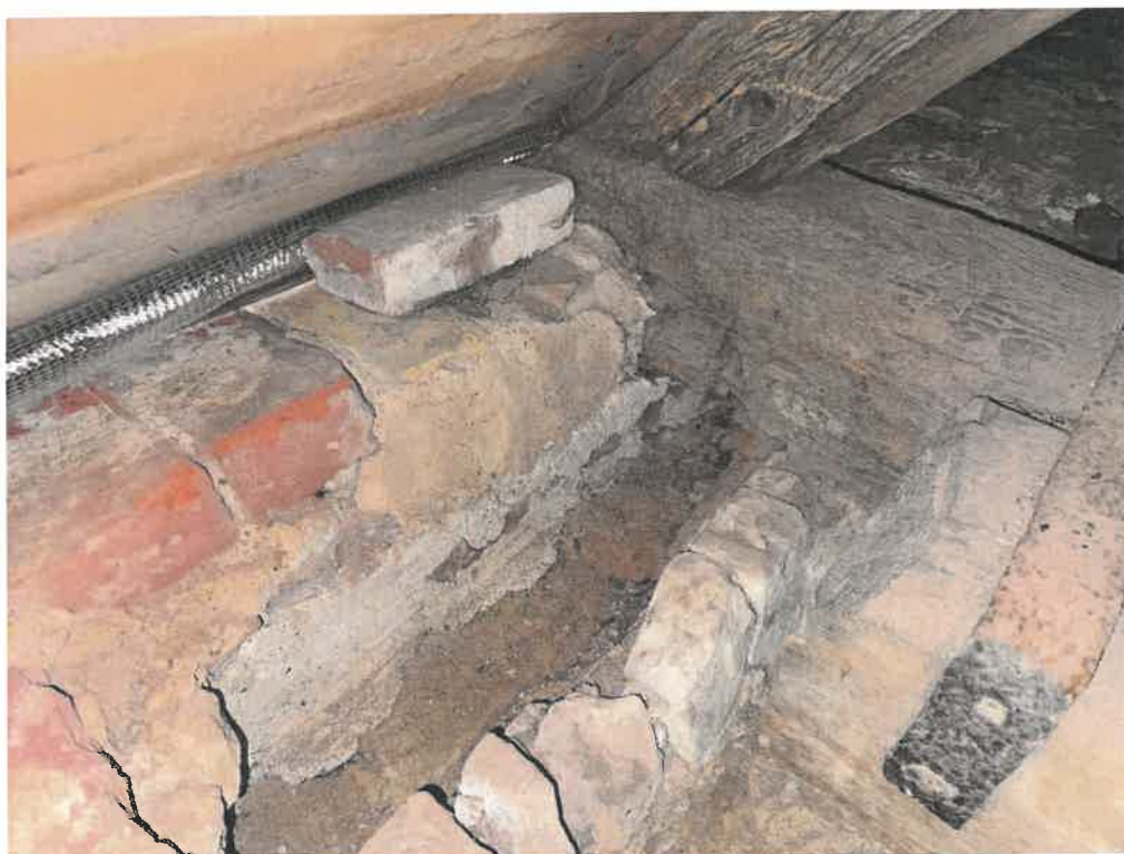
Tårnet. (Som ikke er med i projektet) murremme mangler helt flere steder.
