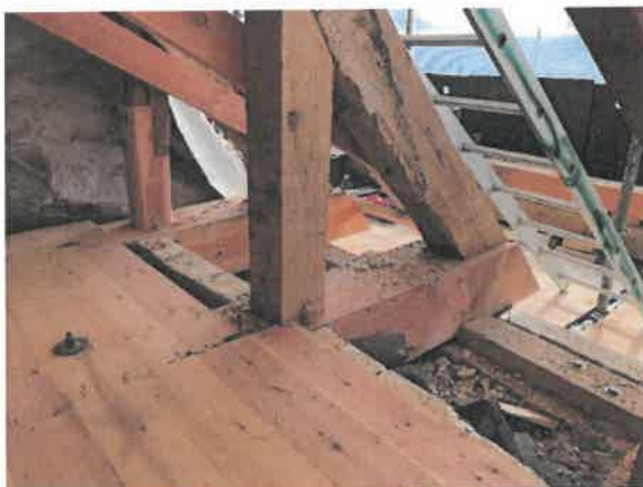
Ny spærstøtte og Istandsatte spærstøtter med løstap i bund. (Billeder fra en anden kirke)
