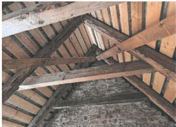
Vindkryds føres fra murrem til kip, hvis det er muligt (Billeder fra en anden kirke)
