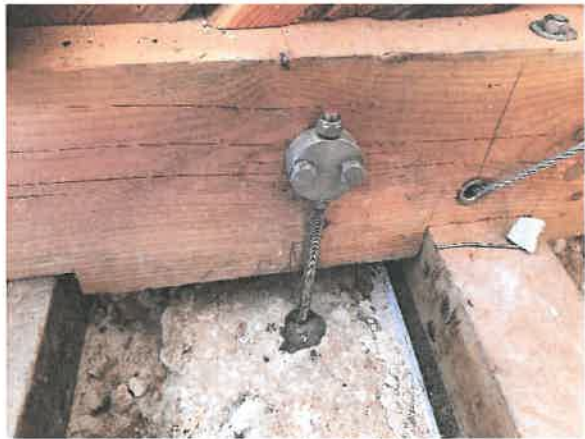
Forankring af tagkonstruktion til murkrone (Billeder fra en anden kirke)
