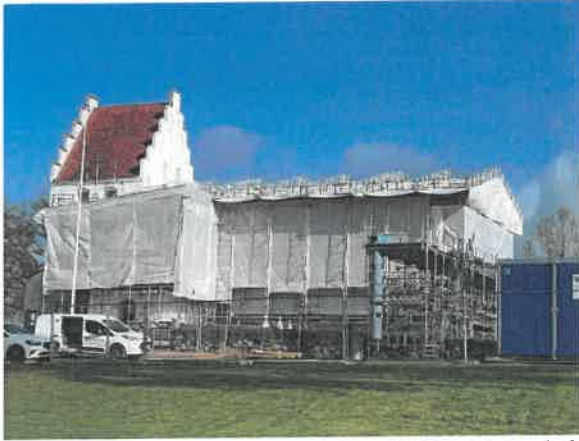
Skib og kor på kirke overdækket. Overdækning set indefra (Billeder fra en anden kirke)
