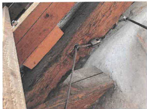
Polygon sammenspænding over hvælv (Billeder fra en anden kirke)
