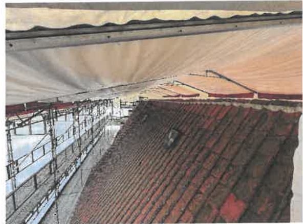
Skib og kor på kirke overdækket. Overdækning set indefra (Billeder fra en anden kirke)
