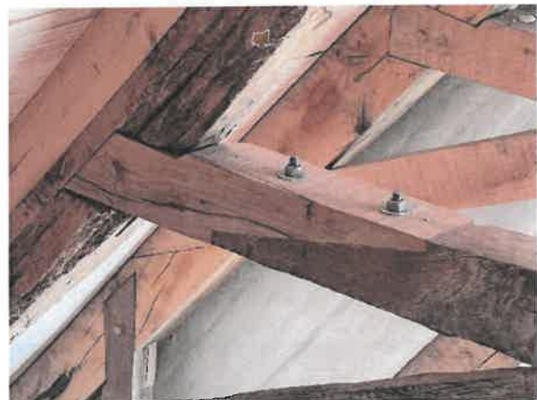
Nyt hanebånd og udlusning på spær, mangler nagle. (Billeder fra en anden kirke)
