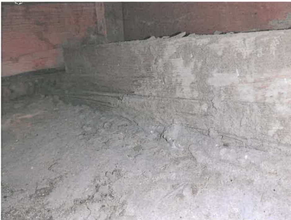
Beton i murkronen i sideskib.
