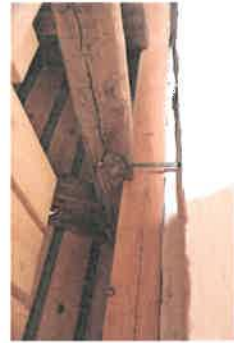
Forankring af tagkonstruktion til murkrone.
