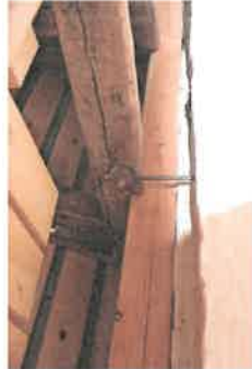
Forankring af tagkonstruktion til murkroner.
