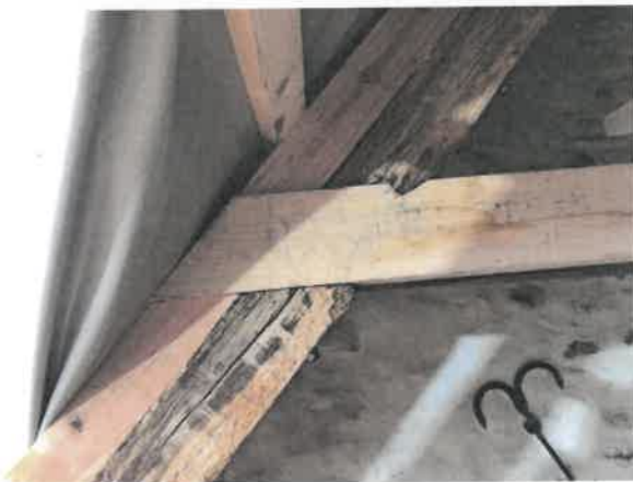
Nyt hanebånd og udlusning på spær, mangler nagle. (Billeder fra en anden kirke)
