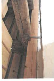
Forankring af tagkonstruktion til murkrone.
