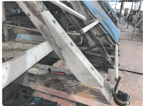
Flere bjælkeender er udlust et stykker i bunden. (Billeder fra en anden kirke)
