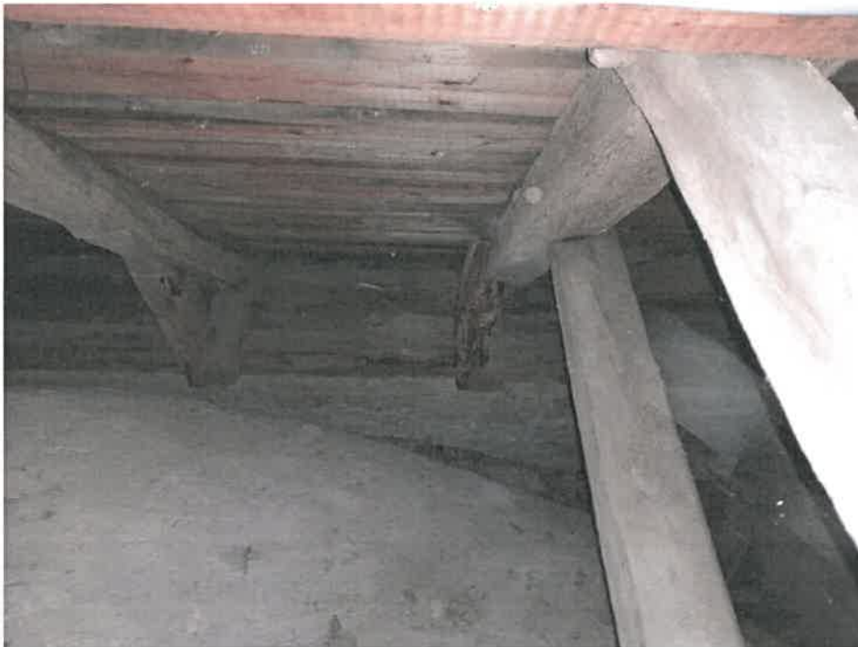
Bindbjælker i sakristiet skåret over.
