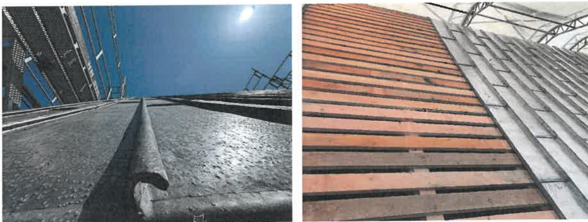
Nyt blytag under udførsel (Billeder fra en anden kirke)
