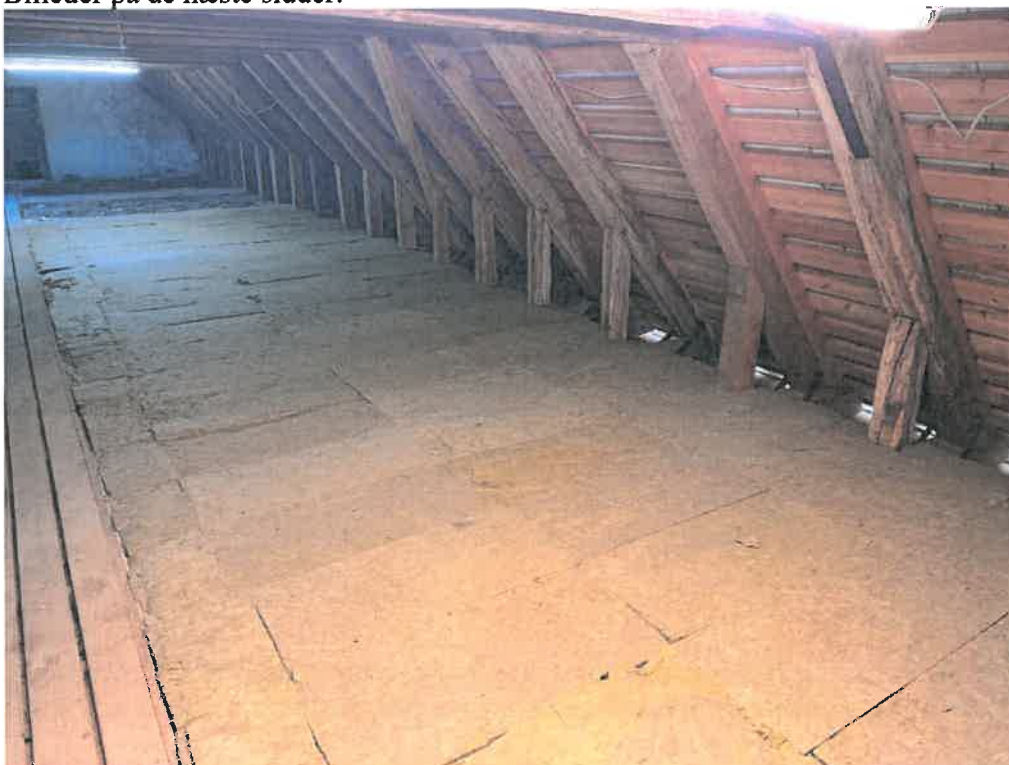
Skibets sydside. Taget og isolering skiftet i 2014. (Mange spær er oprettet)
