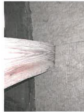
Sydside med isolering op mod spærstøtter
