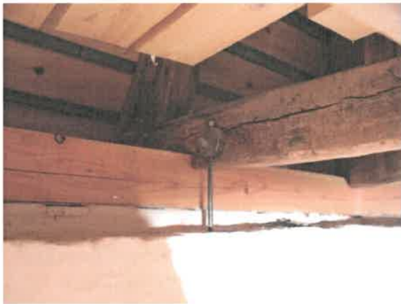
Forankring af tagkonstruktion til murkrone (Billeder fra en anden kirke)
