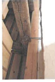
Forankring af tagkonstruktion til murkroge.
