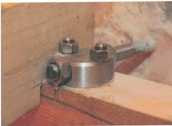
Forankring af gavl til tagkonstruktion med ankerblok (Billeder fra en anden kirke)
