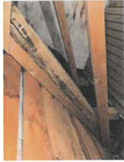
Konstruktiv udlusning boltet og limet til eksisterende spær
