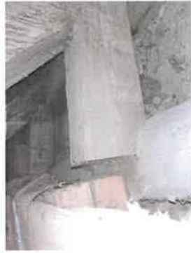
2 bindbjælker er skåret over uden at være samlet
