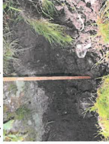
Syddiget snit 1. Dobbeltbandede med græsbelædt digetop. Indvendig digesider er jorddækket. Højde over terræn ca. 100 cm.
