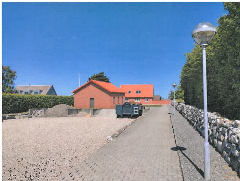
Eksist. menighedshus i baggrunden og nyt maskinhus i forgrunden set fra syd
