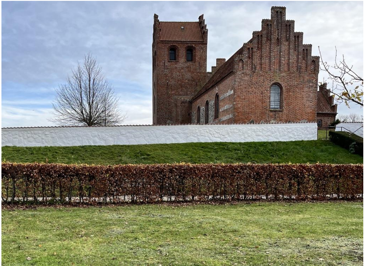
Efter istandsættelse - Mur mod vest
