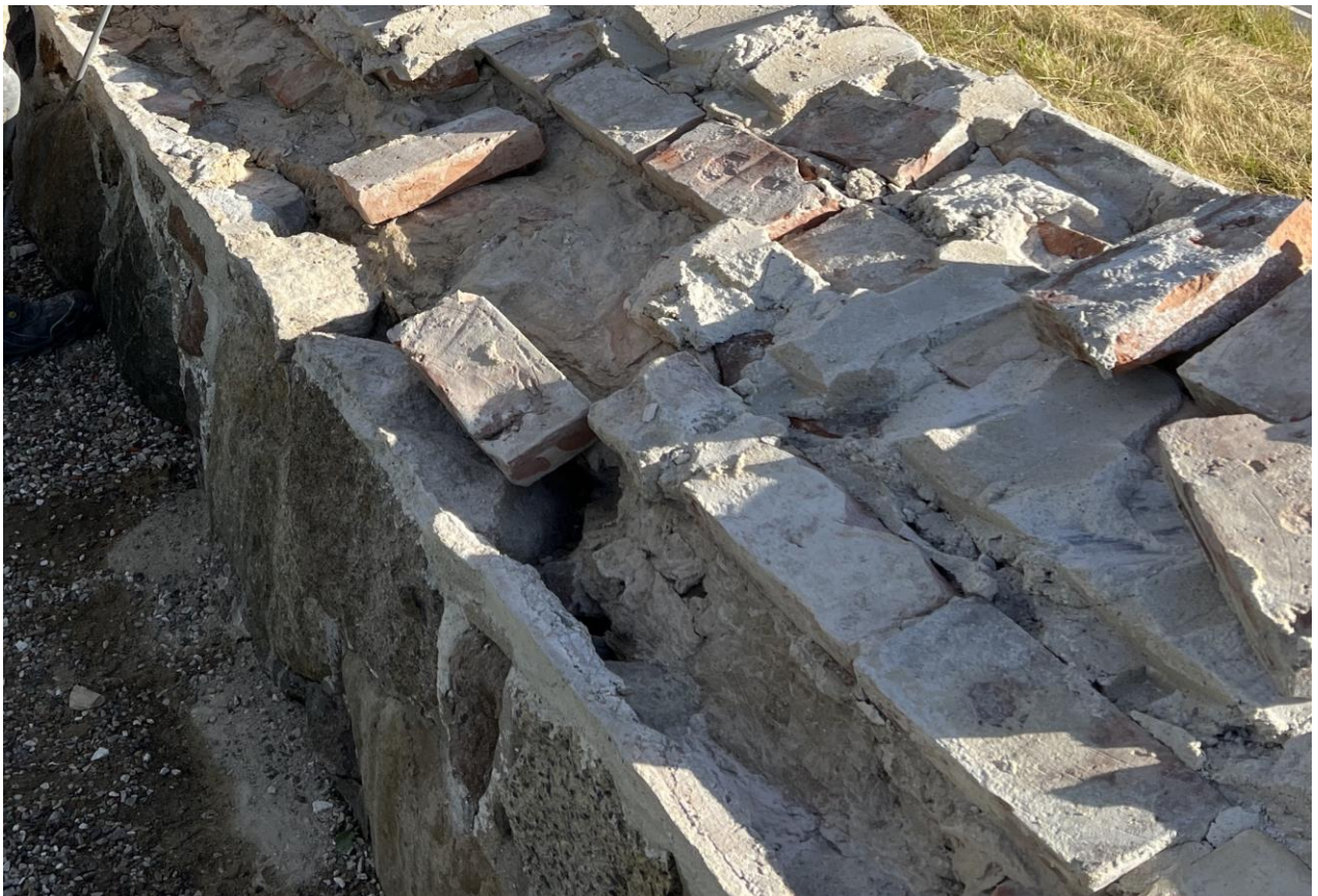
Før istandsættelse - defekt udført læggemørtel fjernet - mur mod nordøst
