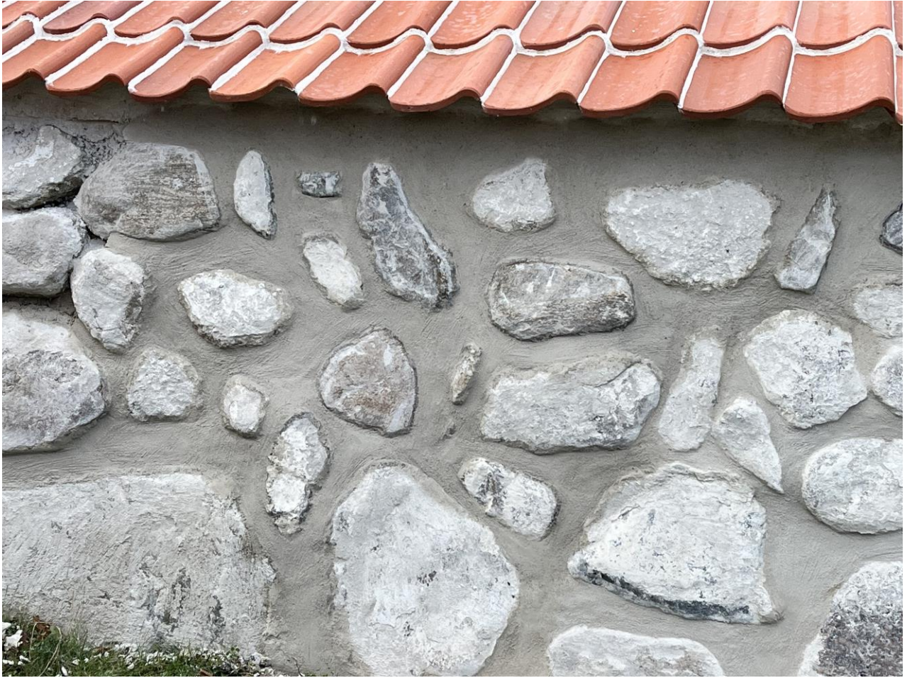
Under istandsættelse - Mur mod vest
