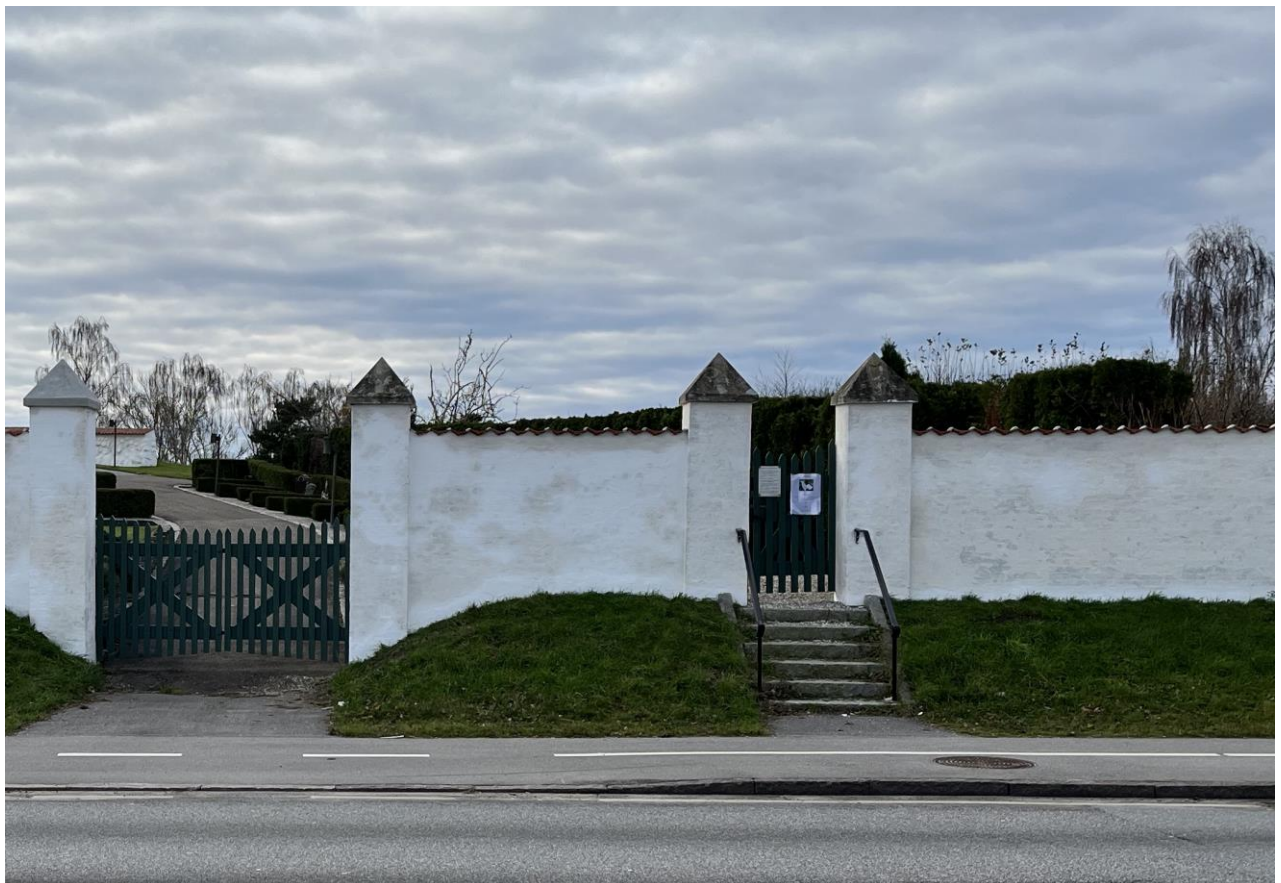
Efter istandsættelse - Mur mod nordøst
