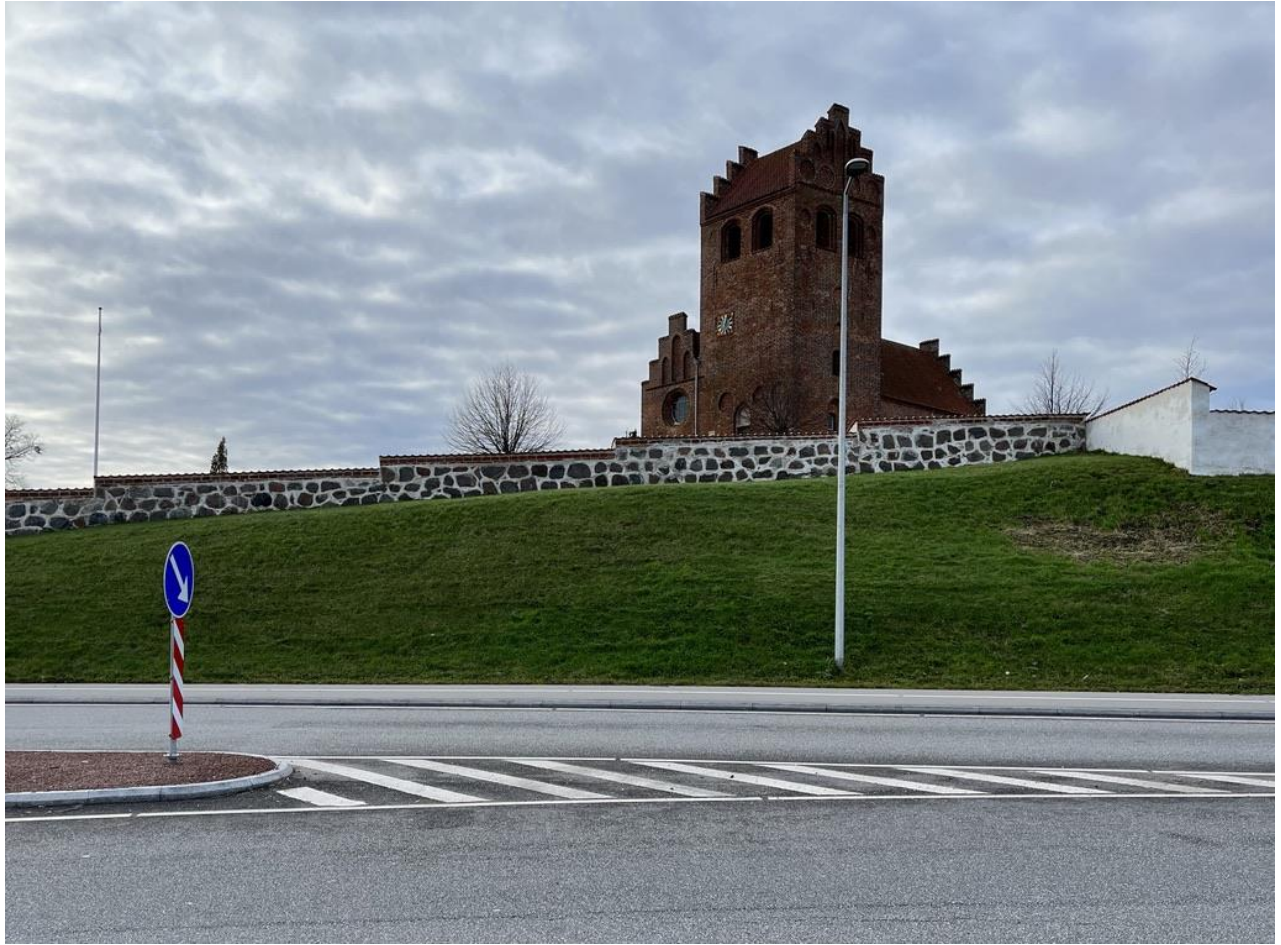
Efter istandsættelse Mur mod nordøst
