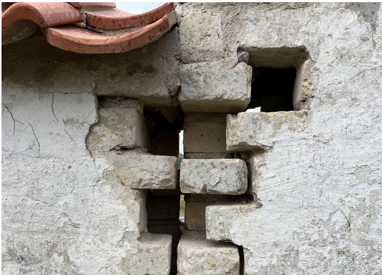
Under istandsættelse - mur mod nordøst
