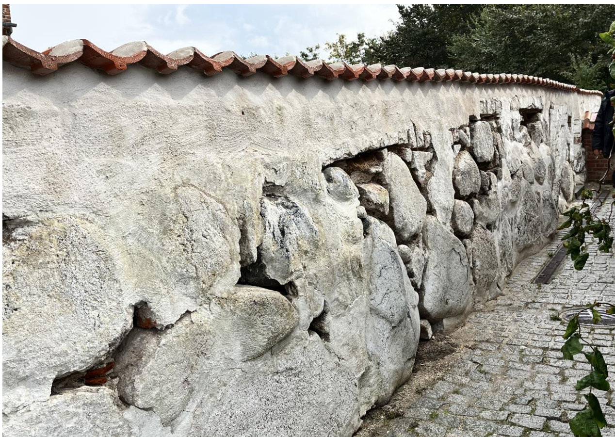
Under istandsættelse - mur mod vest
