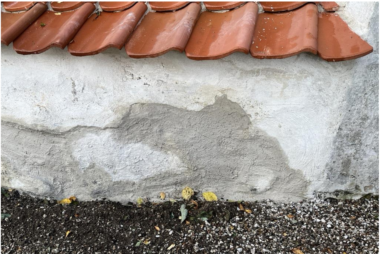
Under istandsættelse - Mur mod syd
