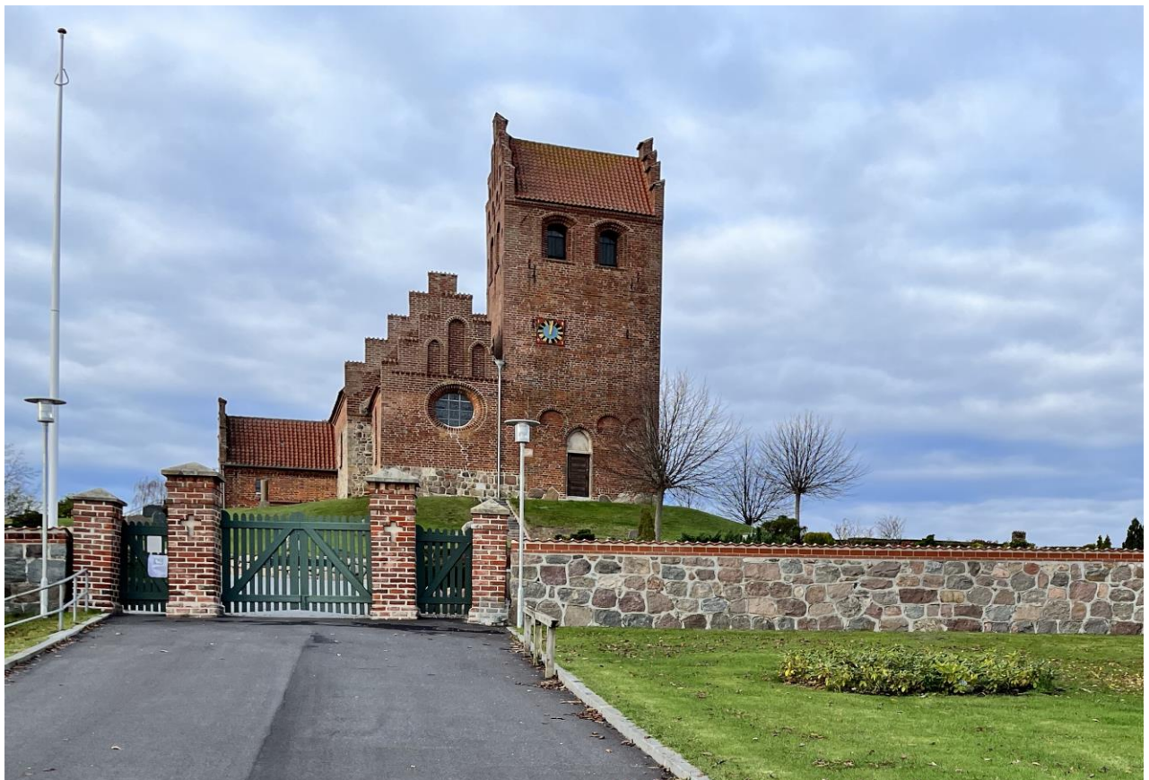
Efter istandsættelse - Mur mod øst
