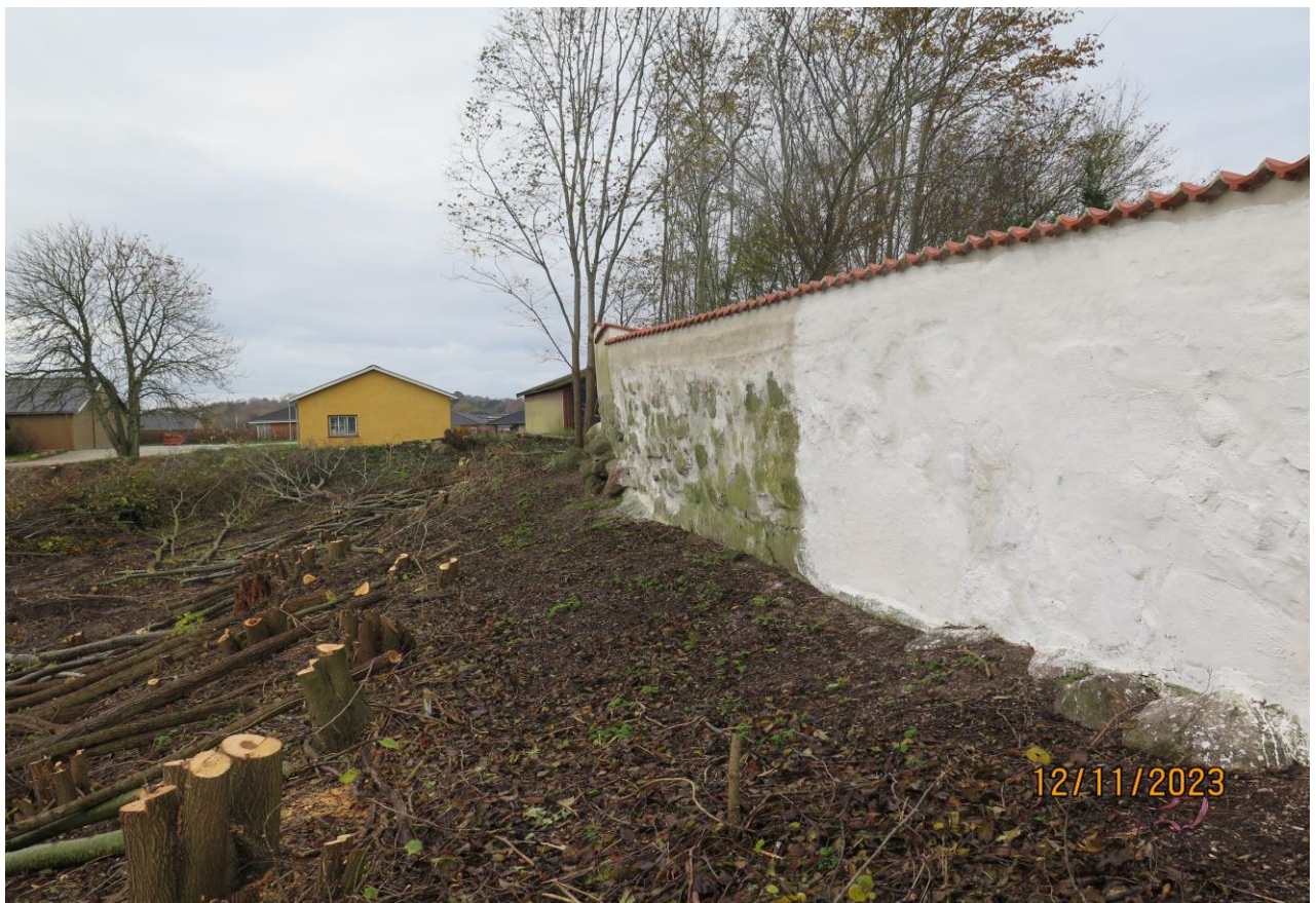
Efter istandsættelse - Fjernelse af beplantning - Mur mod syd
