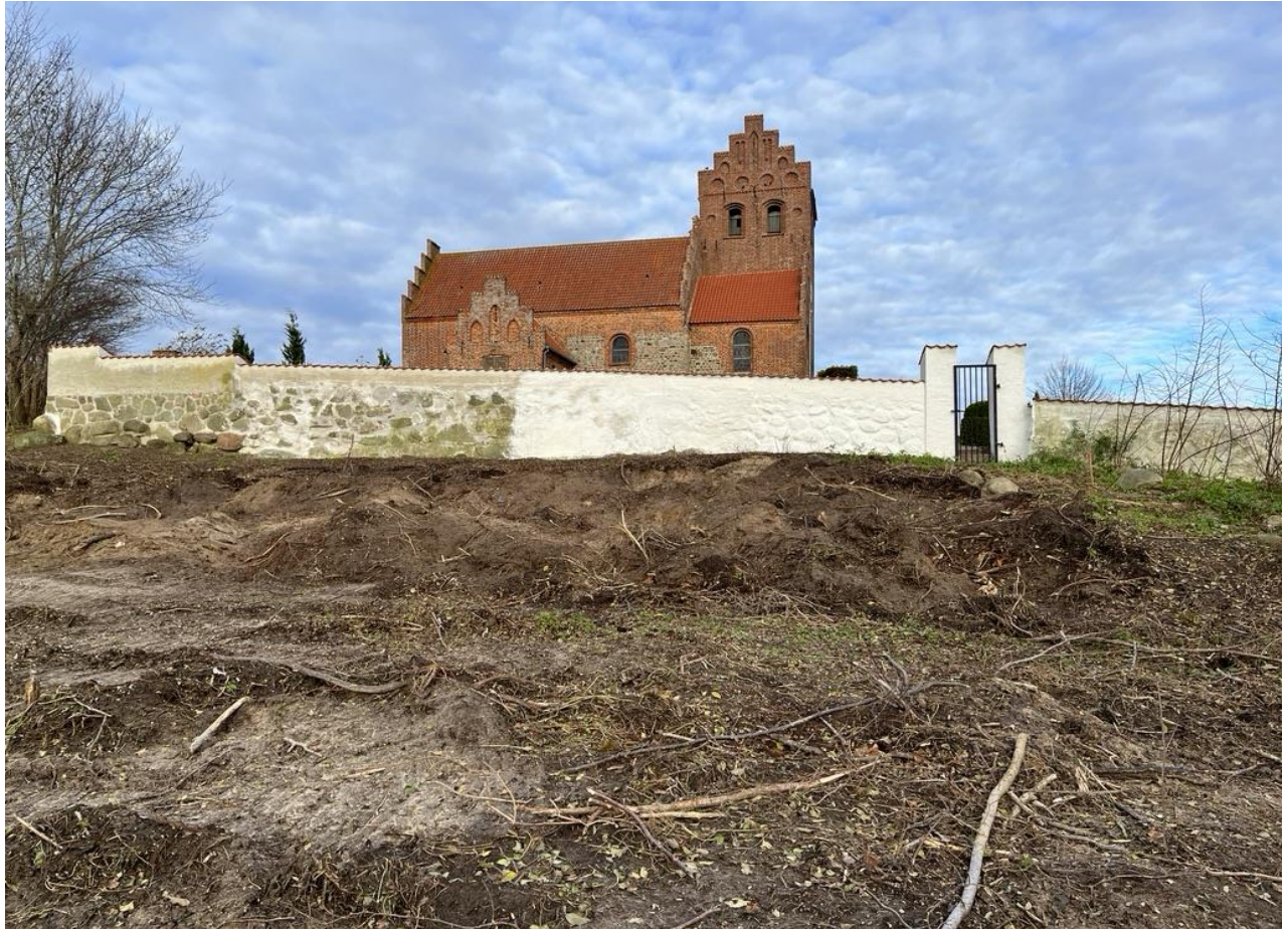
Efter istandsættelse - Mur mod syd - Manglende kalkning grundet beplantning - Nu fjernet
