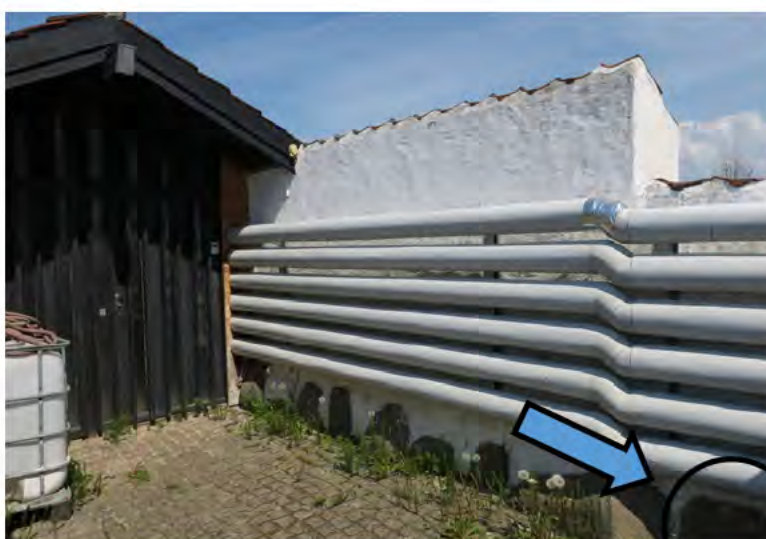
Fig 4 og 5 . Kablet føres i eksisterende kabelbakke, der er placeret på bygningens væg indenfor bygningen og på kirkemuren udenfor.
