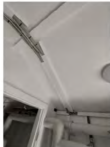
Fig 2 og 3 . Kablet føres i eksisterende kabelbakke frem til og gennem bygningens endevæg -
