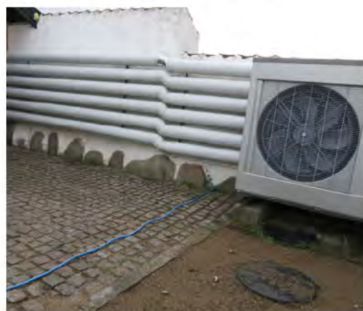
Fig 6 . Kablet føres fra eksisterende kabelbakke—ned under belægning af chaussesten og dækkes med bånd. Linjeføringen er rundt om bygningen
