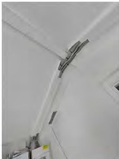
Fig 2 og 3 . Kablet føres i eksisterende kabelbakke frem til og gennem bygningens endevæg -
