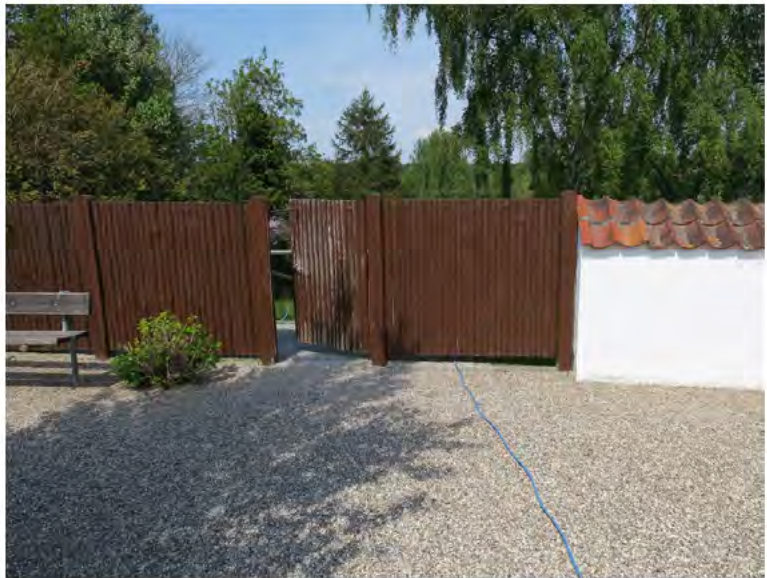
Fig 13. Kablet og renden rammer plankeværksfaget til højre for lågen. Faget er placeret over jord med granitkant i jord højde.
