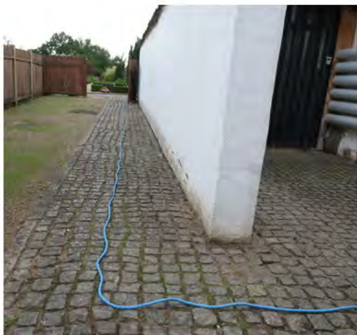
Fig 7. Linjeføringen af kablet er rundt om teknikbygning
