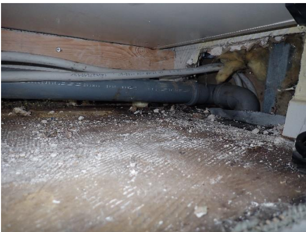
Foto 7: Betongulv under køkkenskabe
