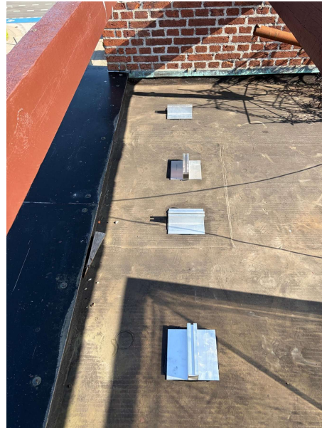
Foto 2. Prøvebeslag placeret på markerede prøvefelter før fastgørelse.
