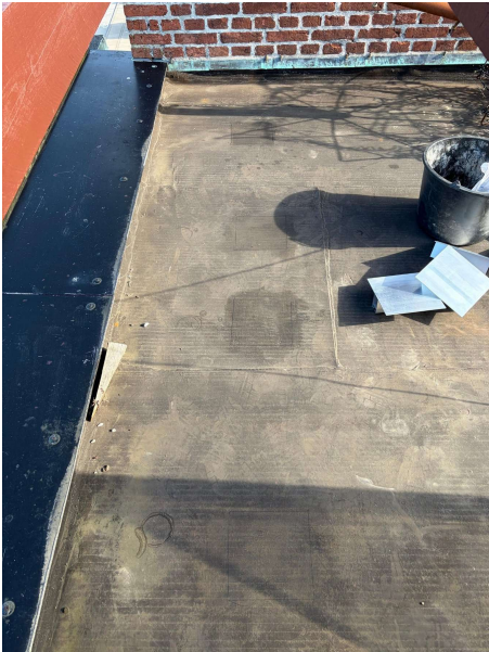
Foto 1. Markerede prøvefelter på tagfladen før montering.
