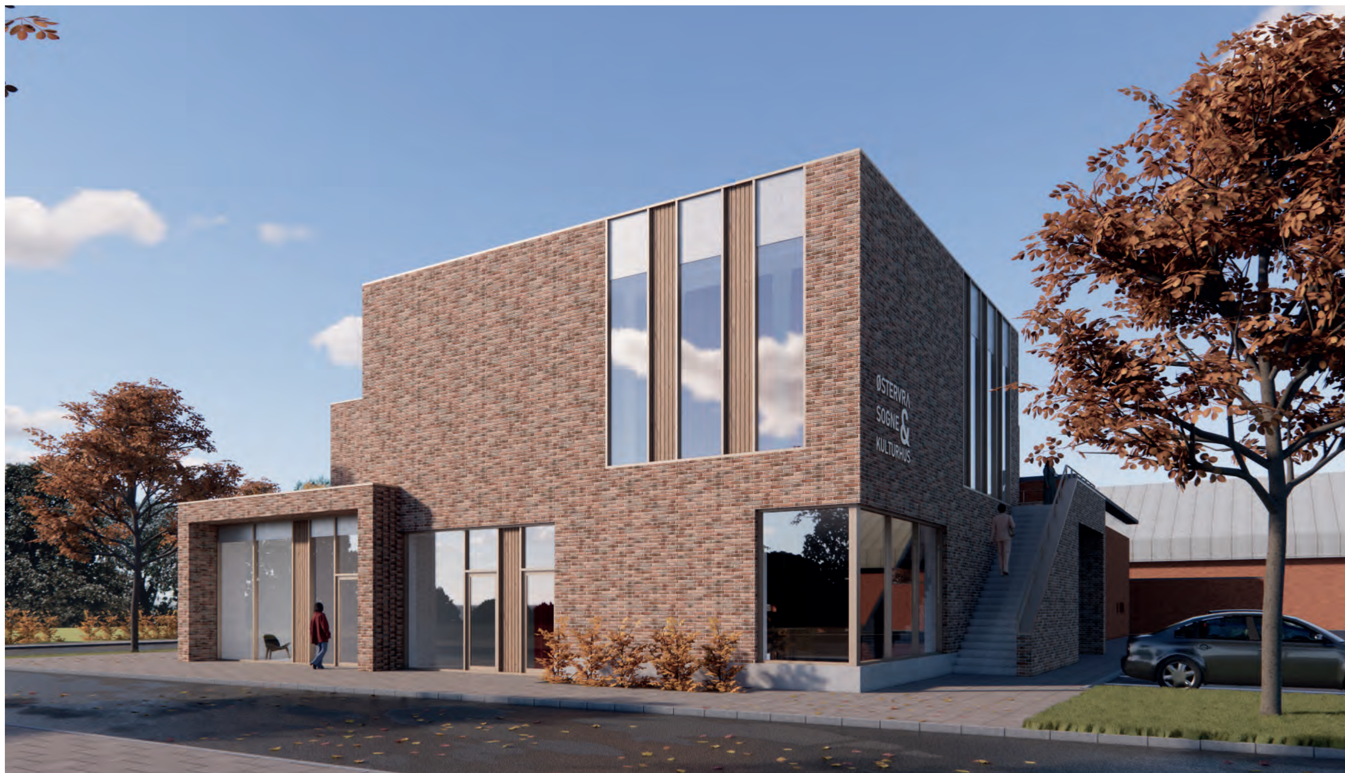
VISUALISERING | FRA NORD MED KIG MOD HUSETS SALE OG DE TO INDGANGE
